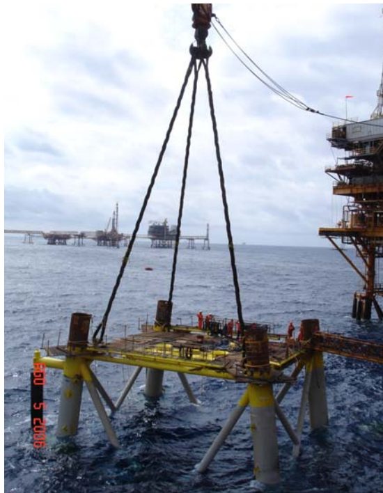
Figura V.4.16. Nivelación de la subestructura.
