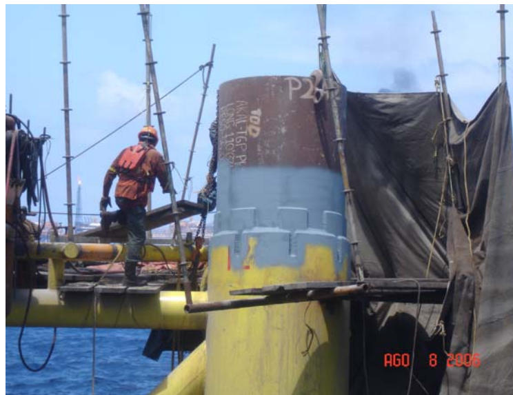
Figura V.4.17. Preparación de coronas en el pilote.
