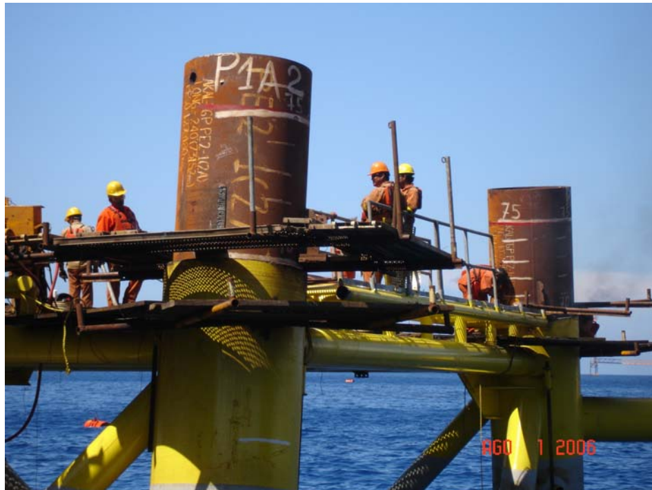
Figura V.4.6 Longitud optima (2-6 ft) para realizar corte de la primera sección de pilote y unión de soldadura del siguiente tramo
