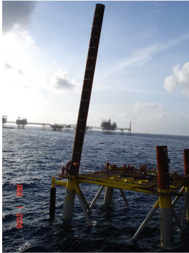
Figura V.4.12 Aplicación de soldadura entre secciones.
