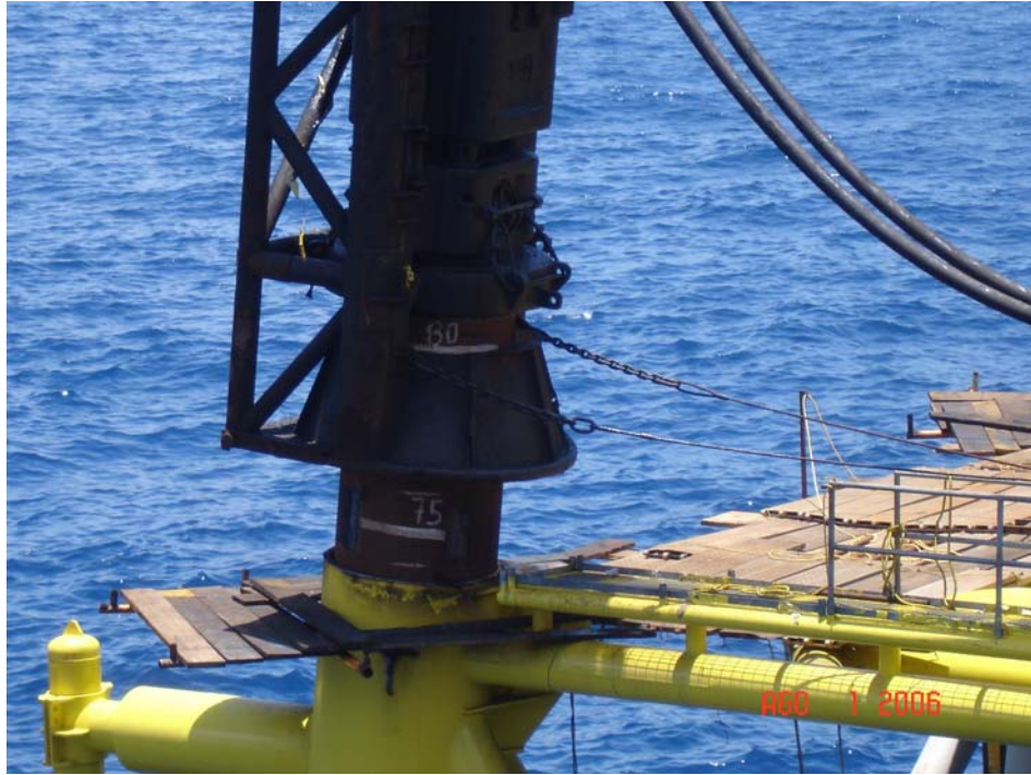
Figura V.4.5 Finaliza hincado de primeras secciones.
