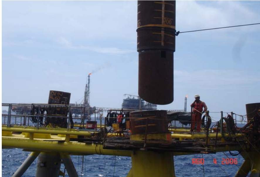
Figura V.4.10 Maniobras de acoplamiento entre secciones.
