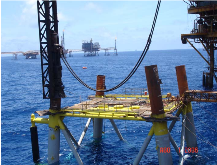
Figura V.4.4 Hincado de primeras secciones.
