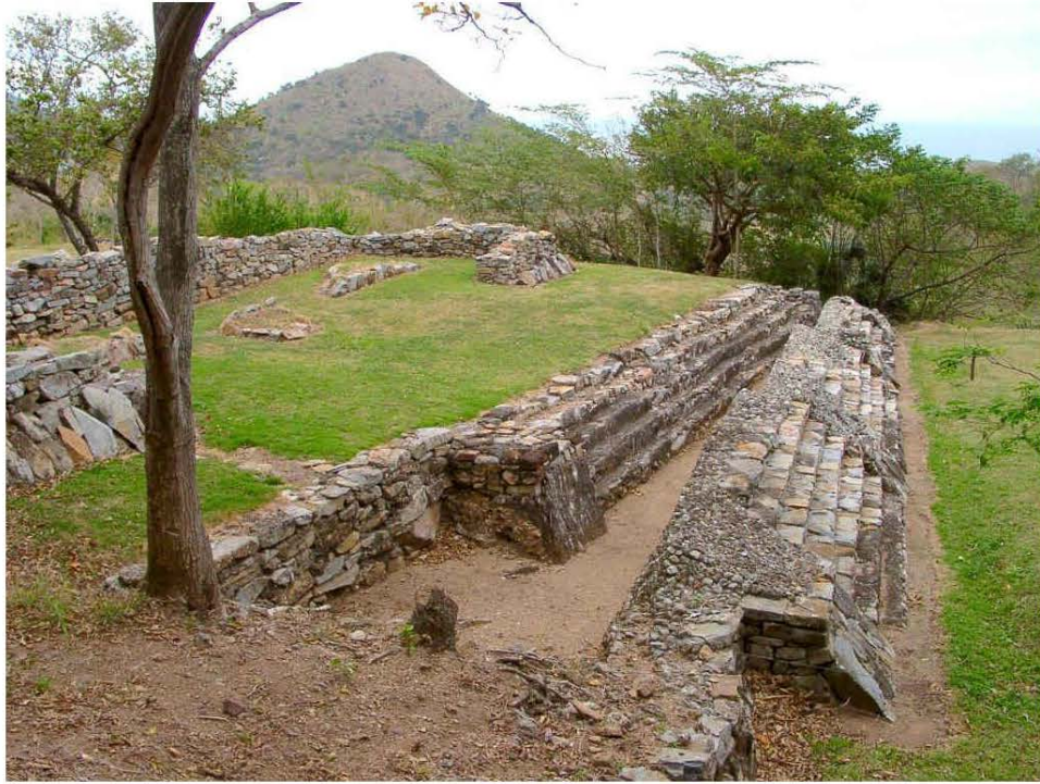
Figura 2.1: detalle de escaleras en el edificio 3
