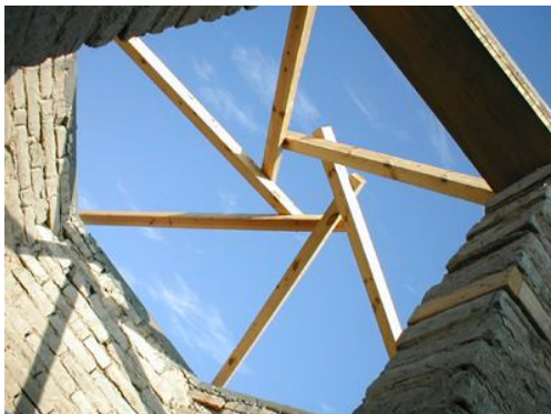
Vigas que sostienen el techo
