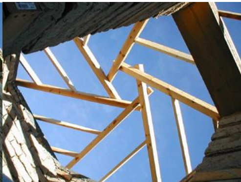
Soportes que ayudan a sostener el techo
