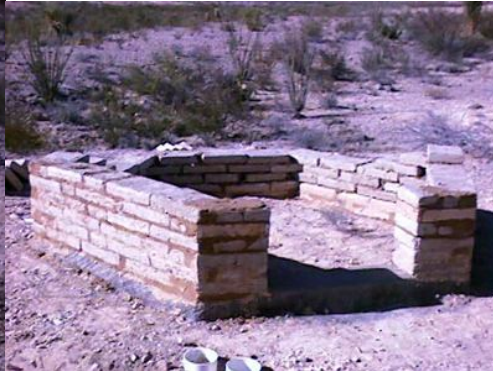
Poniendo las paredes de adobe
