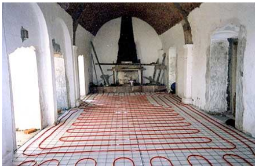
Instalación de mangueras para suelo radiante.
