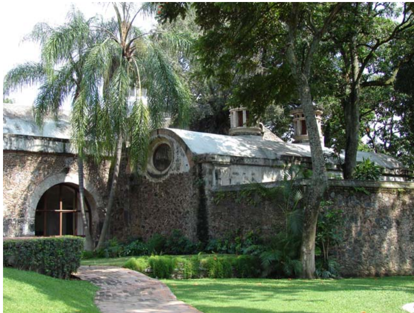
FOTO. RSM. BOVEDA CAÑÓN EN CAPILLA. HACIENDA COCOYOC.
