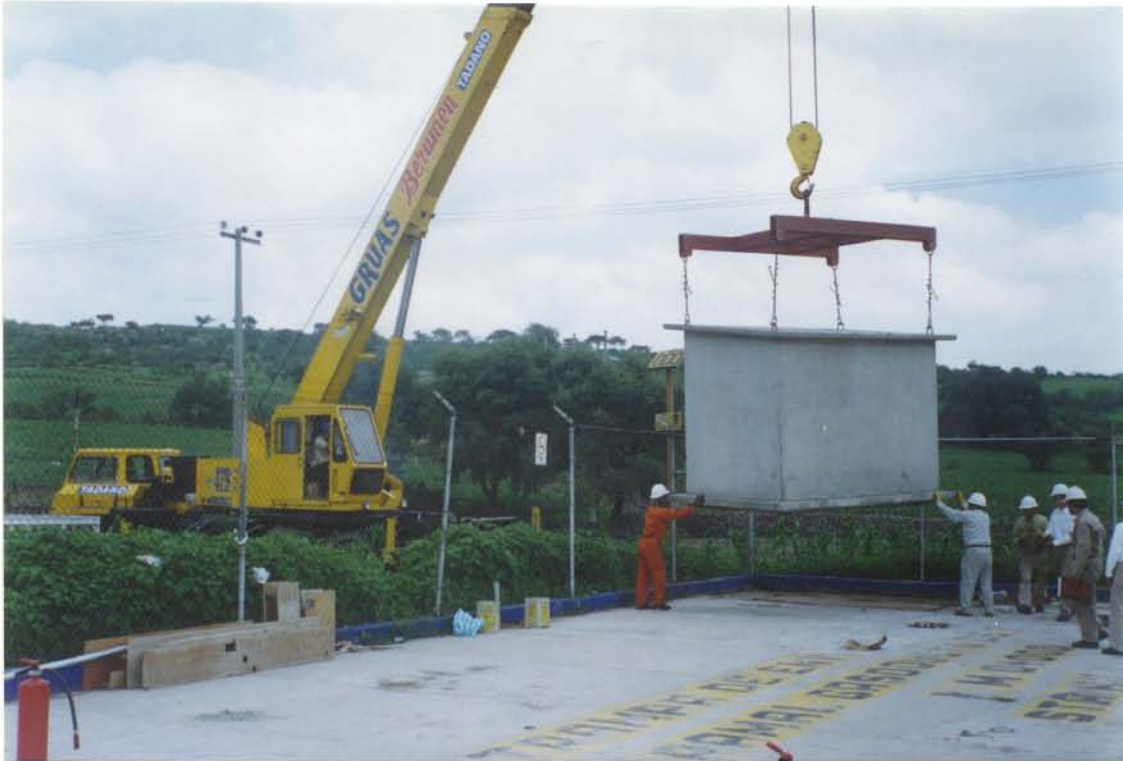
Fig.3 Montaje de Caseta en estación VC-009 Santa Ana
