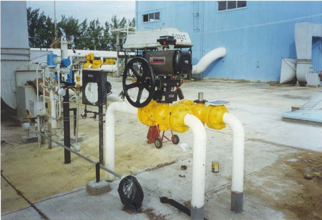
Fig. 7 Vista de un modelo de actuador para válvula de 24"
