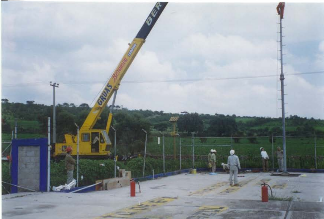
Fig.3 Montaje de Caseta en estación VC-009 Santa Ana
