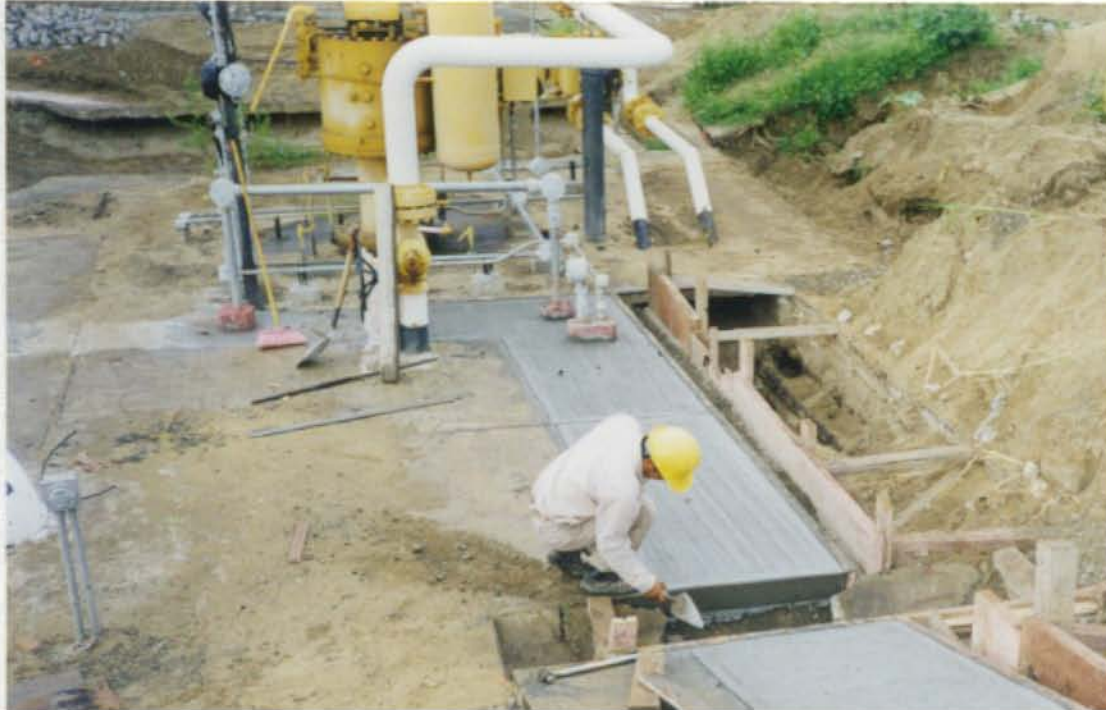
Fig. 11 Vista de Reposición de concreto en excavaciones de canalizaciones
