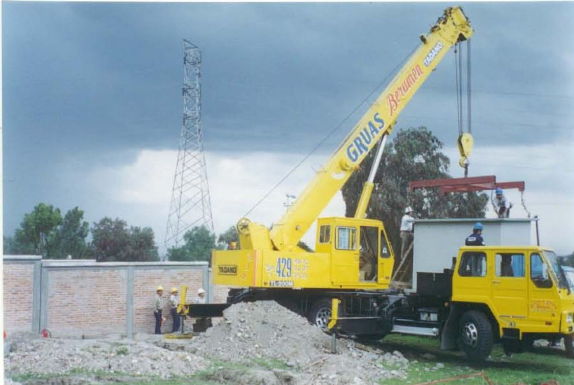
Fig.1 Descarga de la caseta prefabricada en estación VC-010
