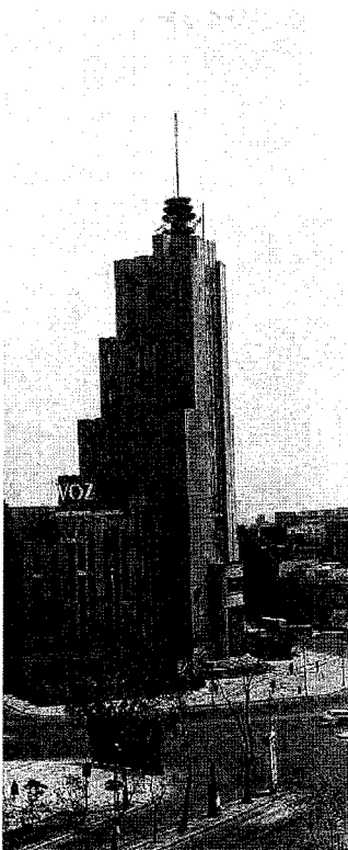
Edificio de la Lotería Nacional. Arq. José Cuevas. 1932-42
