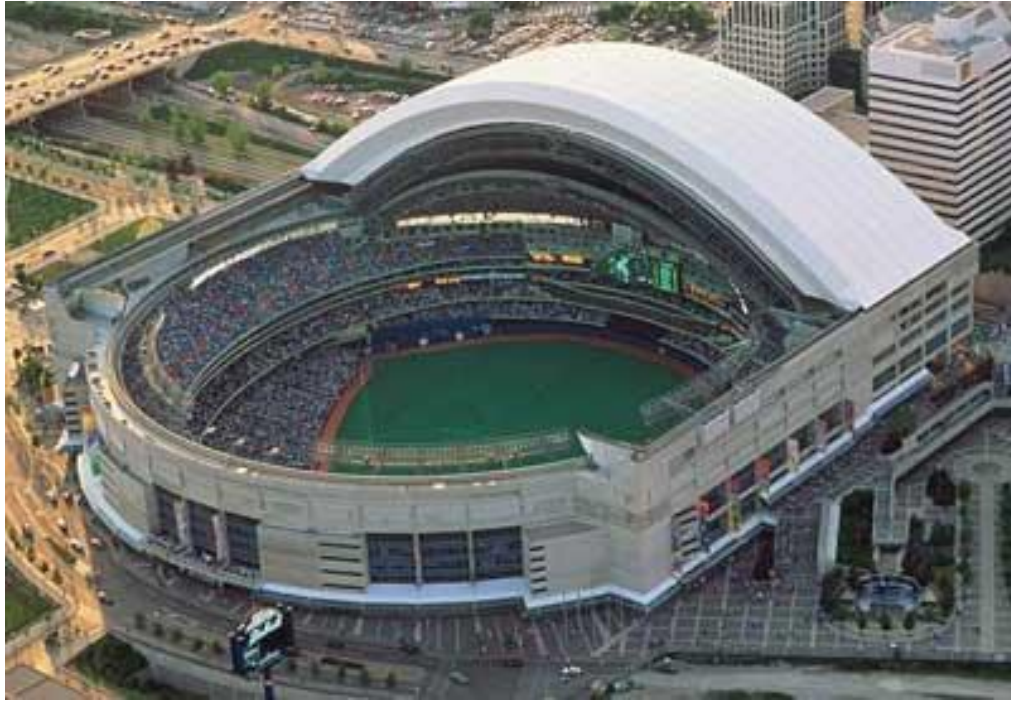
Imagen 2.2.11 Vista aérea del Skydome con el domo abierto
