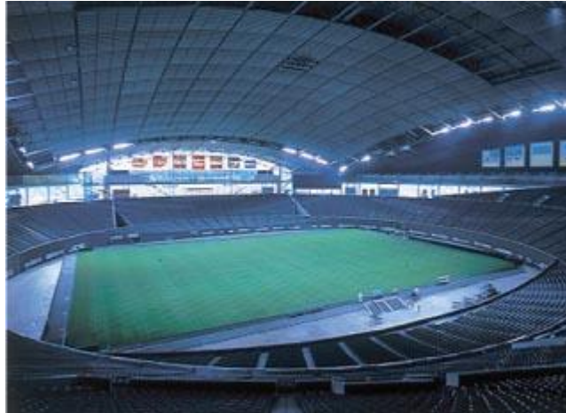
Imagen 2.2.19 La pared móvil es cerrada y los asientos retractables y desprendibles son desdoblados. Esto completa el cambio en el modo de fútbol.
