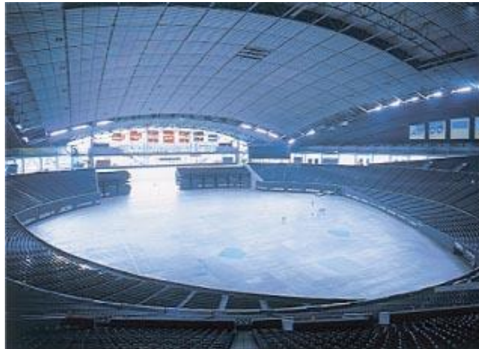
Imagen 2.2.16 La pared móvil abre hacia ambos lados, y al mismo tiempo, los asientos son retraídos.
