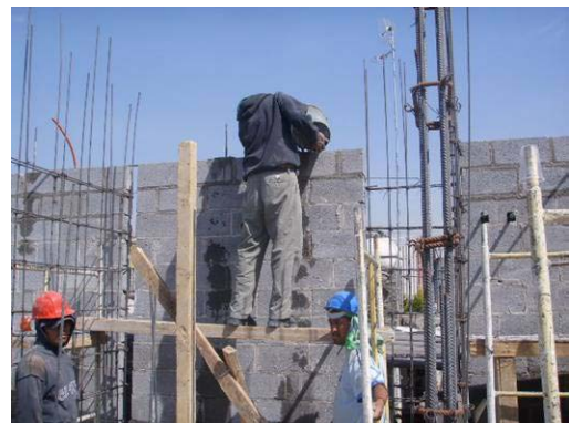
Fue necesario realizar constantes recorridos para verificar que se colocara el refuerzo horizontal de alambón y se colaran los castillos ahogados como se indicaba.
