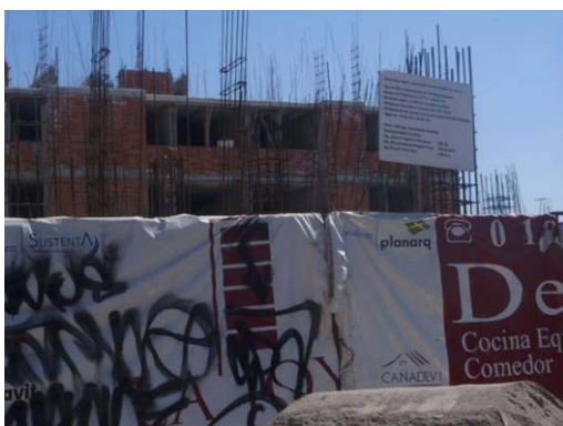
El letrero de la obra debe estar en un lugar a simple vista desde la calle y debe contener todos los datos relacionados con la obra.
