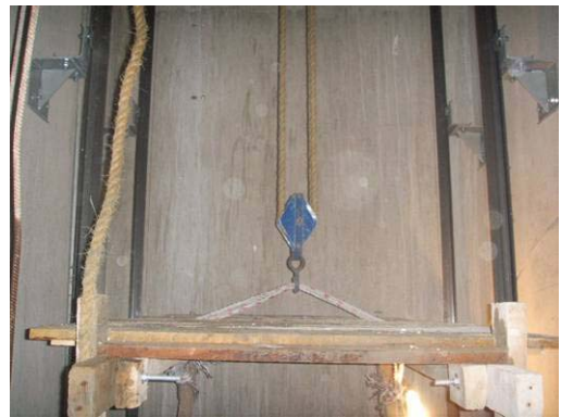
Colocación de los rieles para el elevador del edificio.
