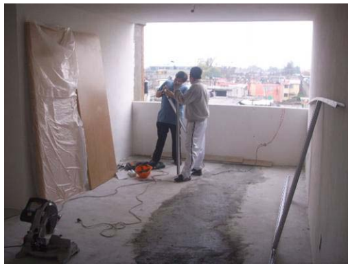
Colocación de puertas y ventanas.
