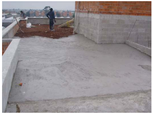
Relleno y entortado de la azotea, previo a la impermeabilización.
