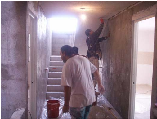
Aplicación de pasta en pasillos y áreas comunes.
