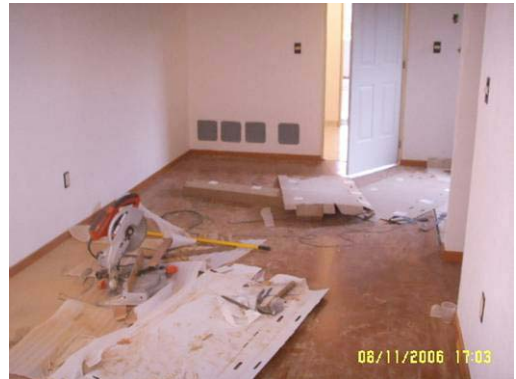
Colocación de laminado de madera en pisos.
