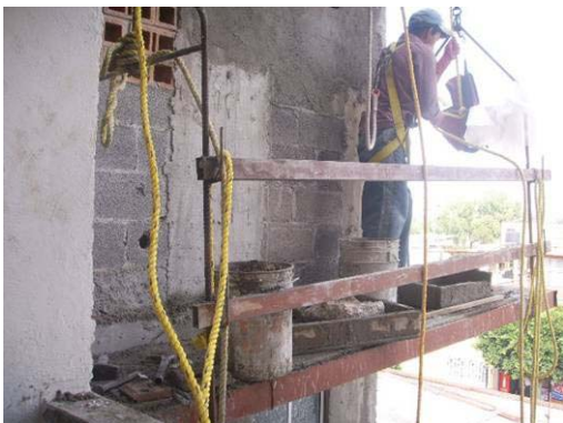
Detallado de los cubos de ventilación.
