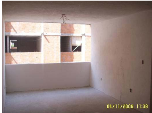
Aplicación de pasta en muros y plafones.
