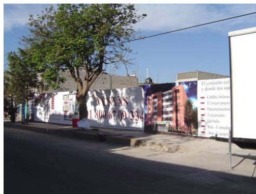
Vista del predio desde calle 4. La colocación de los tapiales debe ser dentro de los parámetros que marca el reglamento (50cm fuera del alineamiento como máximo)
