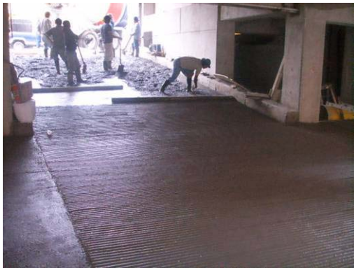
Colado y estriado de la rampa de acceso vehicular.
