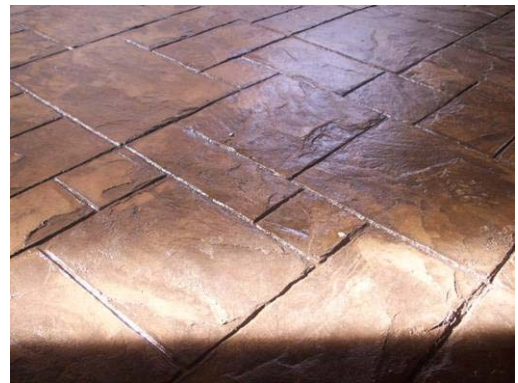
Colado y estampado del piso del vestíbulo en el acceso principal.
