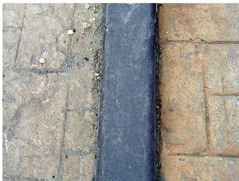
Fig.I.Ñ Guarniciones prefabricadas de fácil colocación
