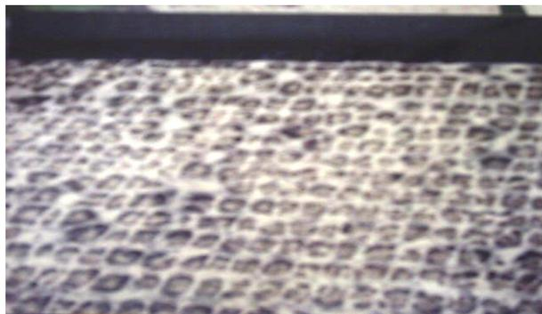
Fig. 3.1 Tanque aireador con un tirante de 500 mm, planta Toluca Oriente trata solo aguas sin materia orgánica con flujo de 25 l/s.
