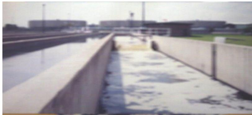
Fig. 3.C Canal de entrada a la rejilla, en la planta de tratamiento de Toluca, Edo. de Méx. Para remover las grandes cantidades de basura y no entorpecer el tratamiento del agua.
