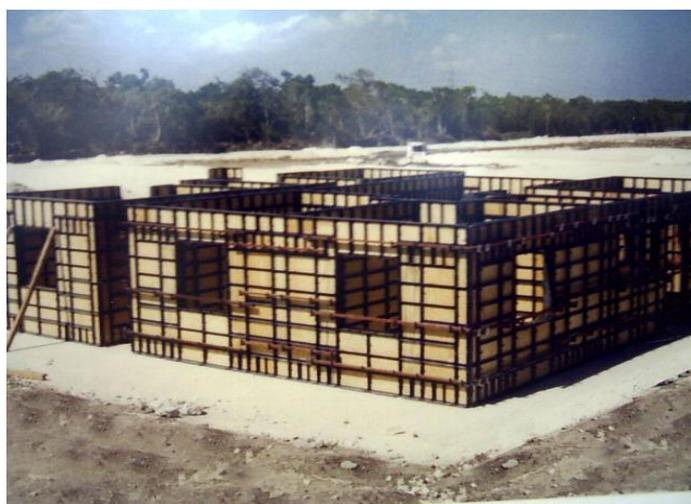
Fig. 1.K Sistema de cimbras deslizables metálicas (Tultitlan Edo de Méx.)
