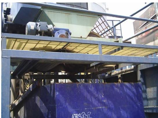
Fig. 3.B Rejillas en la planta de tratamiento Cerro de la Estrella. Se llega a sacar hasta 1 ton. de basura al día; el material de las rejas es de fibra de carbono y polivinilo.
