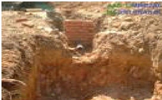
Fig. 3.M Construcción de un pozo de absorción para una escuela Rural en Apizaco Tlaxcala.
