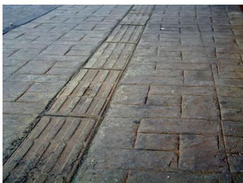
Fig. I.N Banqueta de concreto hidráulico con textura
