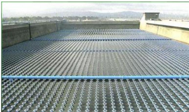
Fig. 3.H Preparación de un tanque aireador, para una procesadora de alimentos lácteos Culiacán Sinaloa México.
