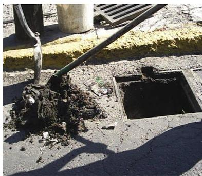
Fig. 5.P Limpieza y desazolve de las coladeras en el Municipio de Naucalpan, Edo. de Méx.
