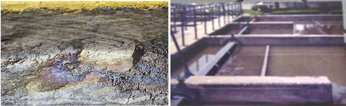
Fig. 3.J Tanque separador de grasas y aceites. Estos son retirados por medio de viguetas que cumplen con un ciclo de cada 45 min. Planta de tratamiento Cerro de la Estrella, Iztapalapa, D.F.
