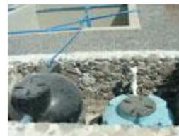
Fig. 5.S Cisternas de captación de agua pluvial en casa habitación, Pachuca, Hgo.
