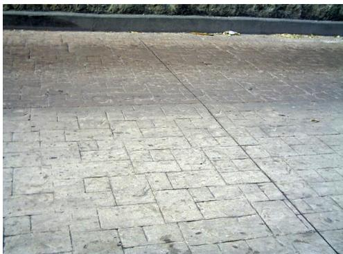
Fig. 1.0 Arroyo vehicular de concreto hidráulico y malla electro soldada.
