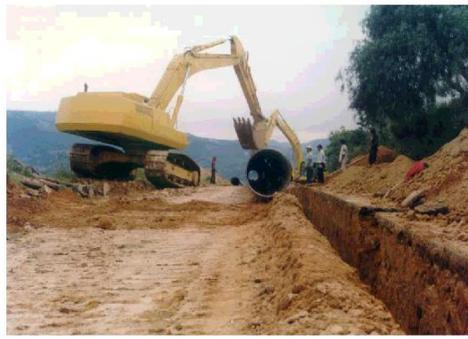
Fig. 5.8 Colocación de la red de distribución de agua potable en Melchor Ocampo Estado de México.
