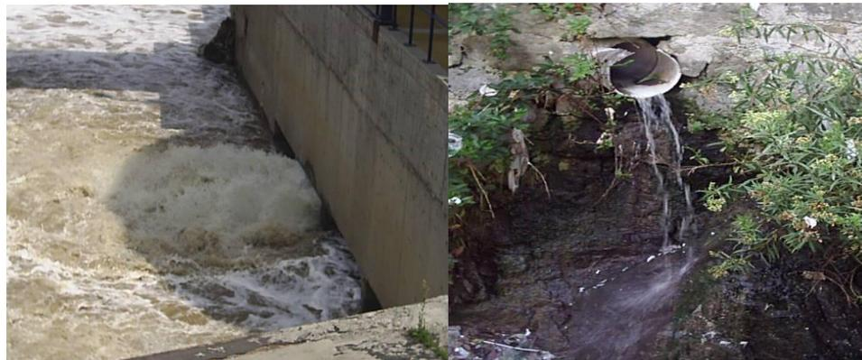
Fig. 2.A A la izquierda, pozo de bombeo Río Hondo, desviando agua del DF hacia el Río de los Remedios en Naucalpan Edo. de Méx. A la derecha, agua residual urbana vertiendo al canal San Lorenzo Naucalpan Edo. de Méx.
