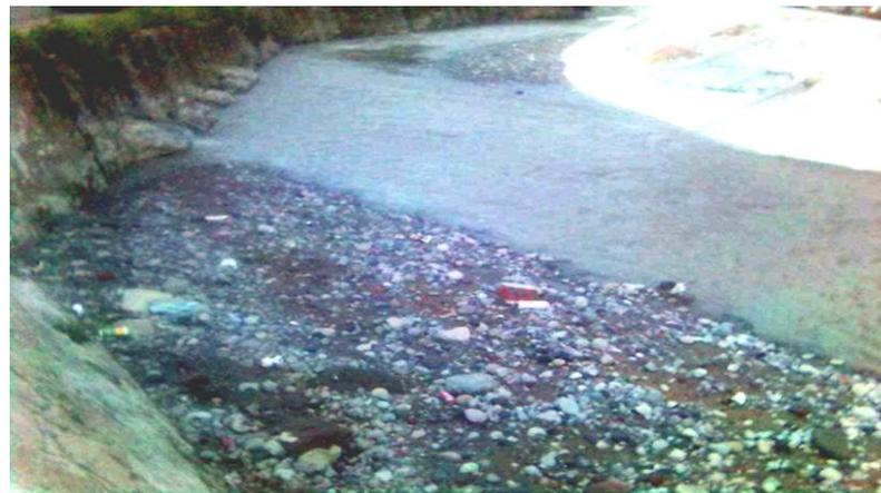
Fig. 2.G Material sedimentado canal de Río Hondo Naucalpan Edo de Méx.
