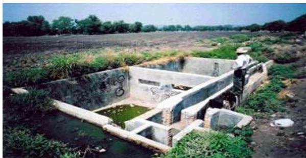
Fig. 5.R Cisterna de captación pluvial en el campo, utilizada para el cultivo de haba en San Juan del Río, Querétaro
