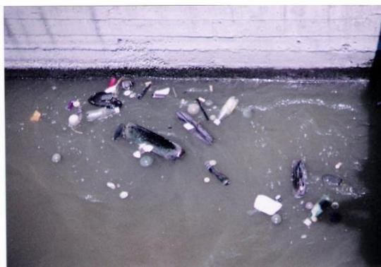
Fig. 3.A Separación de sólidos grandes en la planta de tratamiento Toluca Oriente, Edo. de Méx.
