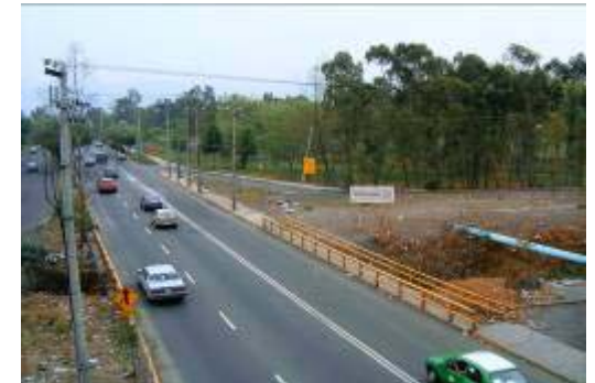
SALIDA DEL TERRENO POR PERIFÉRICO
