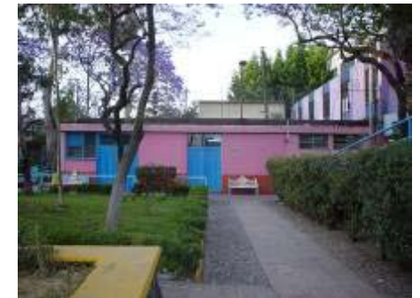
CUARTO DE MÁQUINAS
