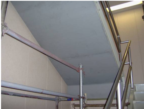
Colocación de placa en la parte inferior de la escalera
