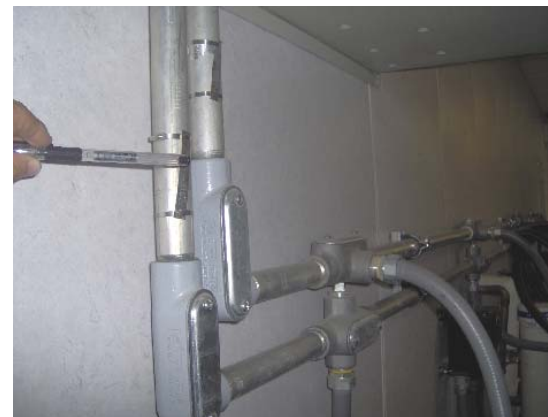
Cierre de pendientes del subsistema 906.08 (PP-5903)
