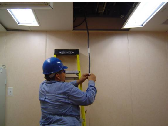
Instalación del cable coaxial de las señales de antena VHF
