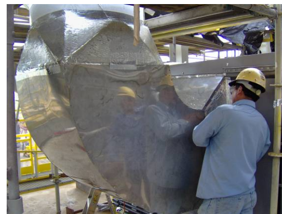
Colocación de protección mecánica a los ductos del HVAC en 5º. nivel.
