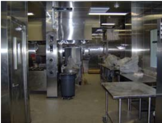
Recorrido de terminación mecánica del subsistema 099.01 (cocina)
