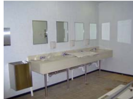
Colocación del mobiliario del baño en 5º nivel.
