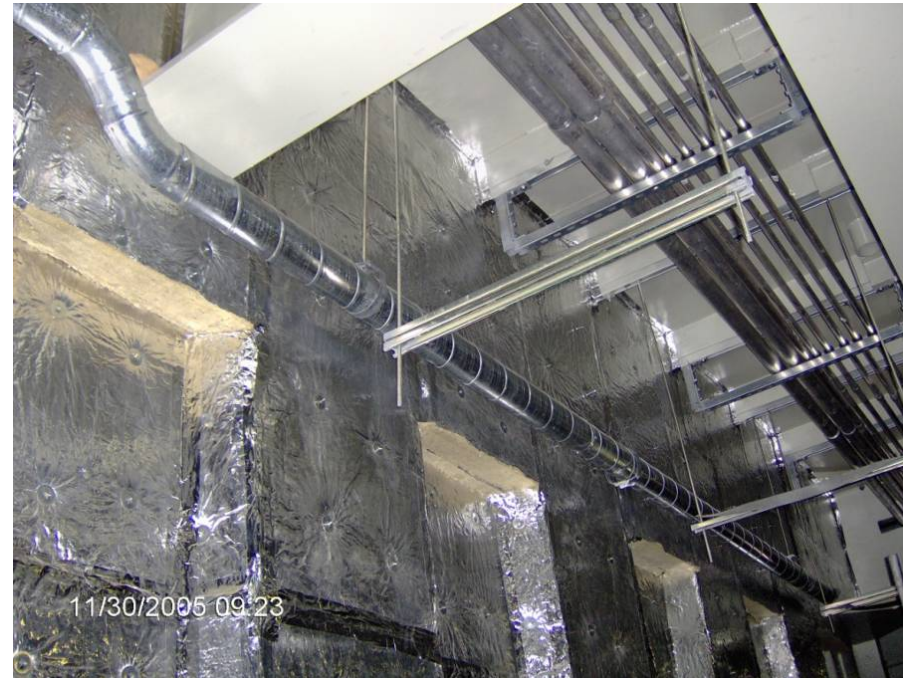
5.- Doble capa de aislamiento termico en los muros exteriores.
