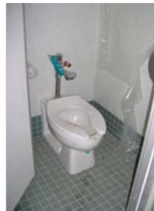
Colocación de mobiliario en los baños en 4º. nivel.
