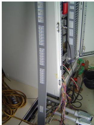
Alambrado del gabinete del sistema de intercomunicación y voceo en 5º. Nivel.
