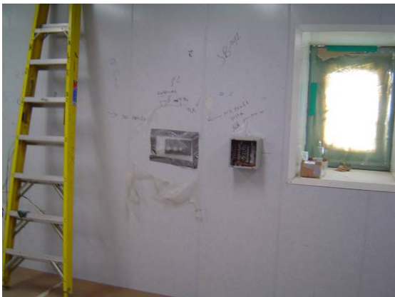
Instalación del sistema de música ambiental en 5º. Nivel.
