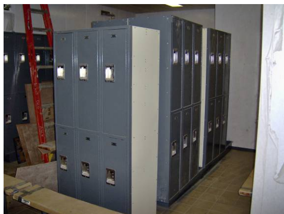
Colocación de mobiliario de los vestidores en 1º. nivel.
