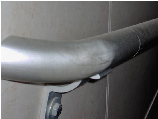
Colocación de barandales en 3º nivel.
