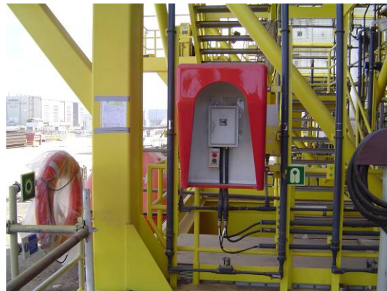
Instalación de estación exterior del sistema de intercomunicación y voceo en 1º. Nivel.
