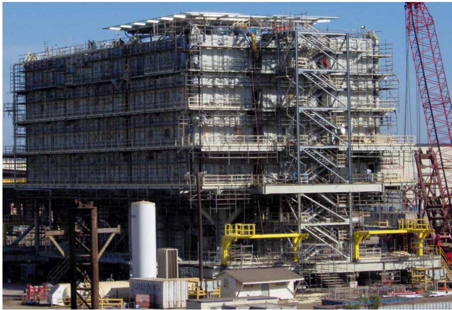
1.-Sitio de construcción, plataforma habitacional HA-KU-M.
