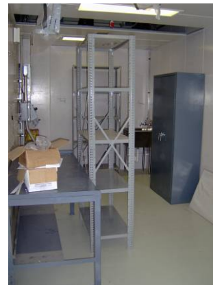
Colocación de mobiliario de talleres en 1º. nivel.
