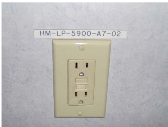
Cierre de pendientes del subsistema 905.01 (LP-5900 y LP-5901) en 1º. nivel.
