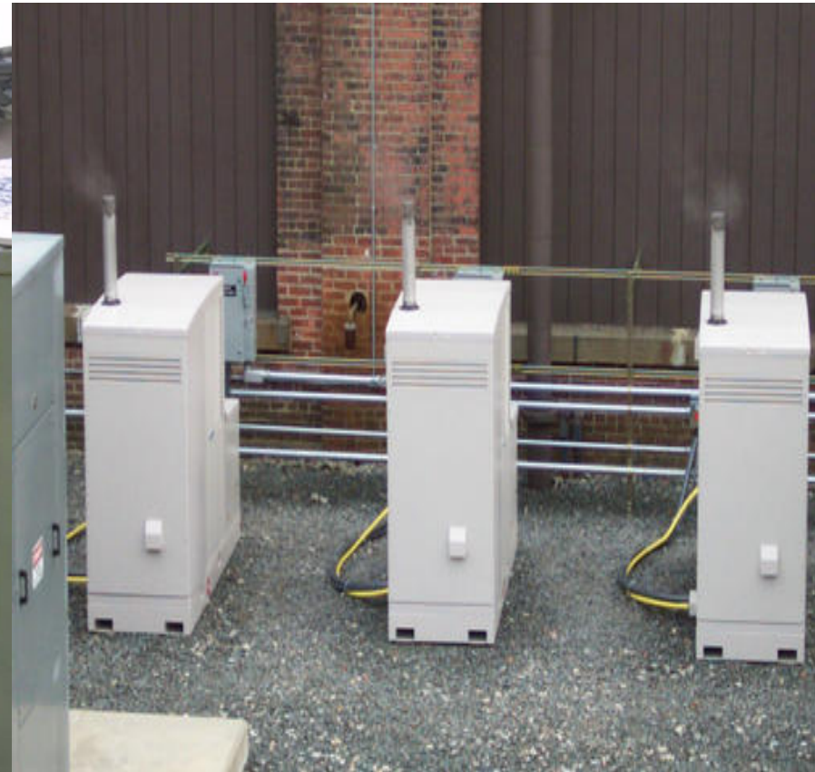
7.- Celdas de Hidrógeno de 1.8 Kilowatts/Hora.
