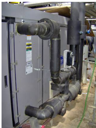
Colocación del aislante térmico en las tuberías del agua fría en 5º. nivel
