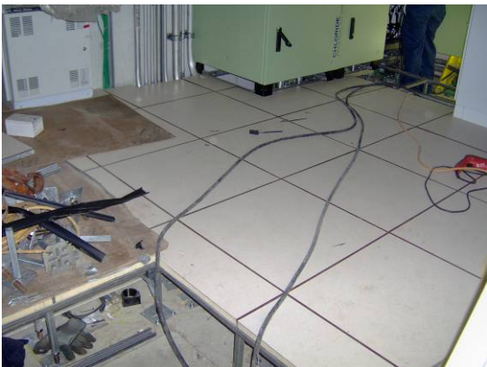
Instalación del piso de falso en 5º. nivel.
