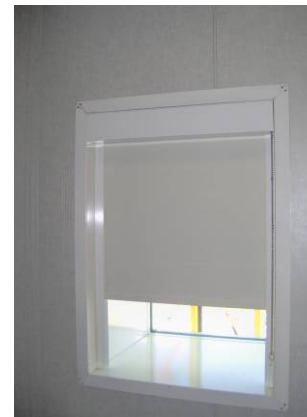
Colocación de persianas en las ventanas en 5º nivel.
