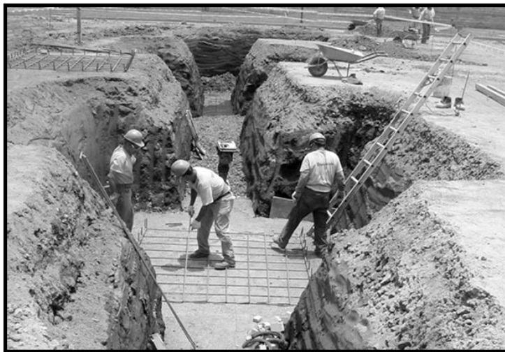
Figura 4.22. Excavación de zanjas
