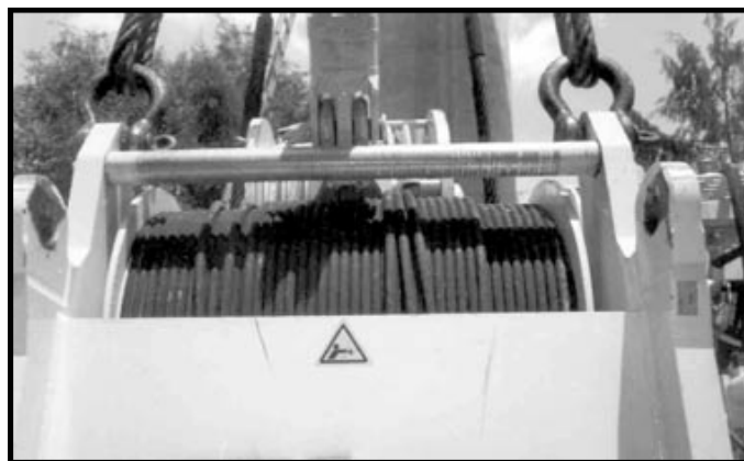
Figura 4.14. Preparación de la maniobra con grúas
