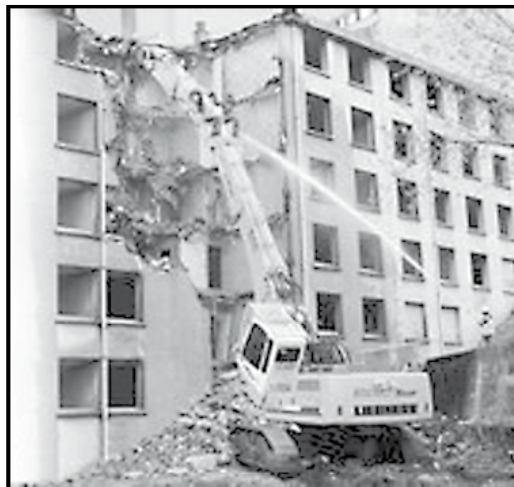
Figura 4.27. Trabajos de demolición con maquinaria
