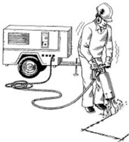
Figura 3.1. Control del ruido de una compresora: cierre las tapas, use amortiguador de ruido en el martillo neumático, póngase orejeras.
