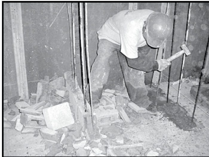
Figura 4.24. Trabajos de demolición manual
