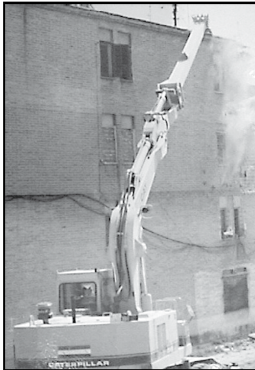
Figura 4.26. Trabajos de demolición con maquinaria
