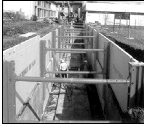
Figura 4.23. Apuntalamiento de zanjas
