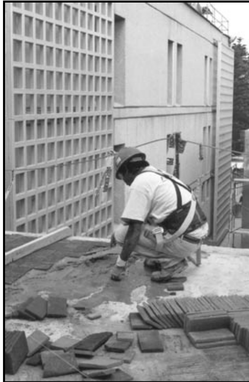
Figura 4.20. Enladrillado de losa
