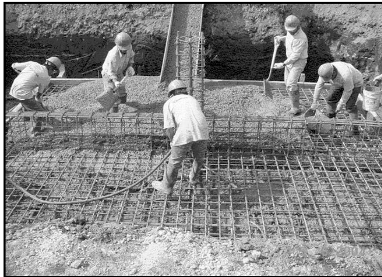
Figura 4.10. Uso de vibrador de concreto
