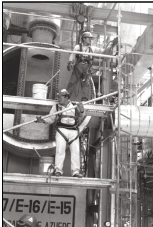
Figura 4.6. Armado de andamio tubular
