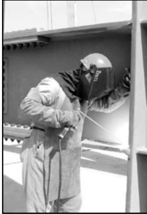
Figura 4.19. Trabajos de soldadura eléctrica
