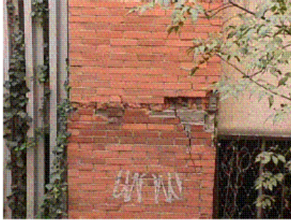
Vista exterior de los niveles inferiores de la fachada Norte
