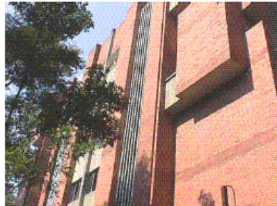
Vista de la fachada Sur
