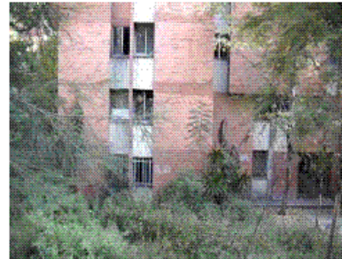
Vista exterior de los niveles inferiores de la fachada Poniente
