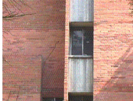
Vista exterior de los niveles intermedios de la fachada Poniente
