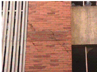
Vista exterior de los niveles intermedios de la fachada Norte
