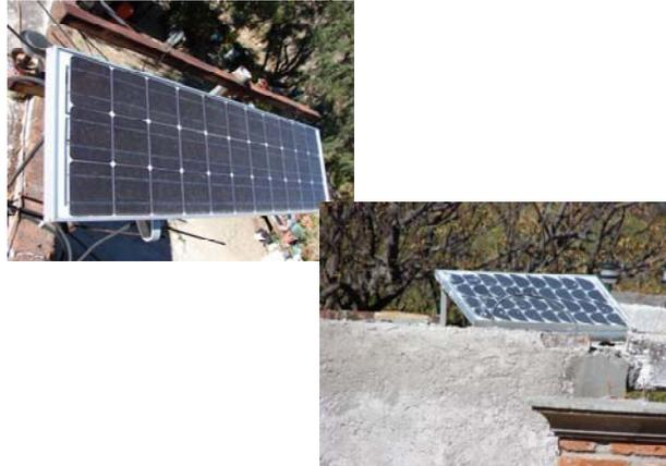
Imagen 5.23 Detalle de algunos p neles instalados en la zona norte
