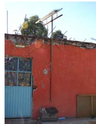
Imagen 5.20 Sistema fotovoltaico instalado en una vivienda rural
