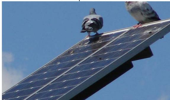
Imagen 5.14 Detalle del daño a un panel solar provocado por las aves
