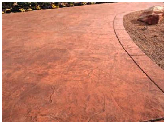
IMAGEN 130.- EJEMPLO DE CALZADA TERMINADA
