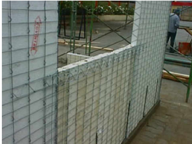
IMAGEN 133.- MURO DE CONVINTEC
