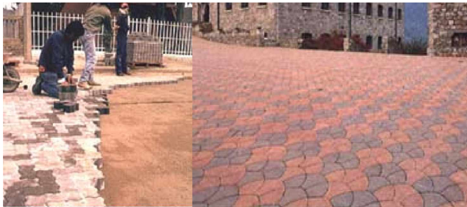
IMAGEN 131.- COLOCACIÓN DE ADOQUÍN Y ÁREA FINAL
