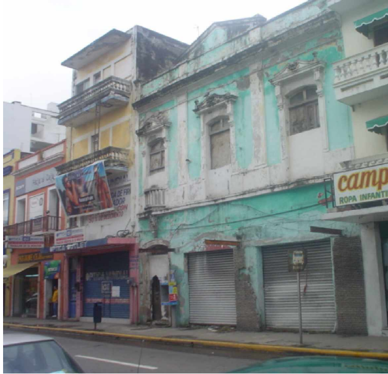
IMAGEN 6.- CALLE 5 DE MAYO CASO 1 EDIFICIO COMPLETAMENTE CERRADO Y EN ABANDONO
