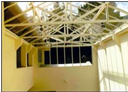
IMAGEN 1.- RECONSTRUCCIÓN DEL TECHO DE INMUEBLE
