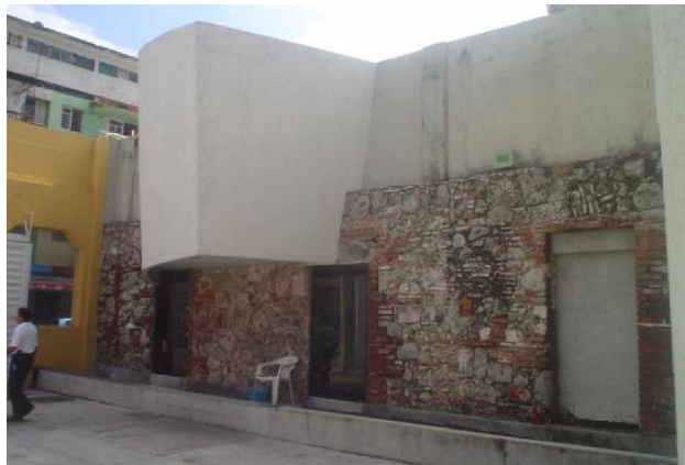
IMAGEN 71.- MURO EXTERIOR LOCALIZADO EN EL ESTACIONAMIENTO
