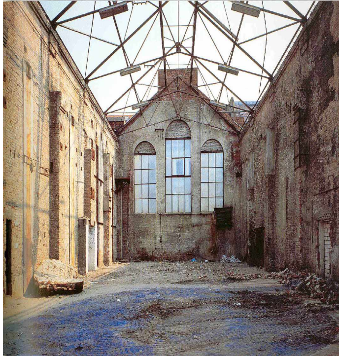
IMAGEN 66.- ÁREA DESPEJADA ANTES DE LA RECONSTRUCCIÓN
