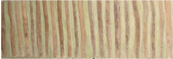
muro construido a base de troncos de madera y una especie de adobe.
