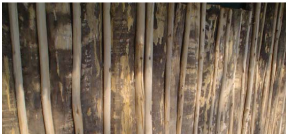
muro de tablones de madera colocados en vertical junteados con varas.
