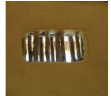
celosia en ventana en muro de mampostería con varas de madera.
