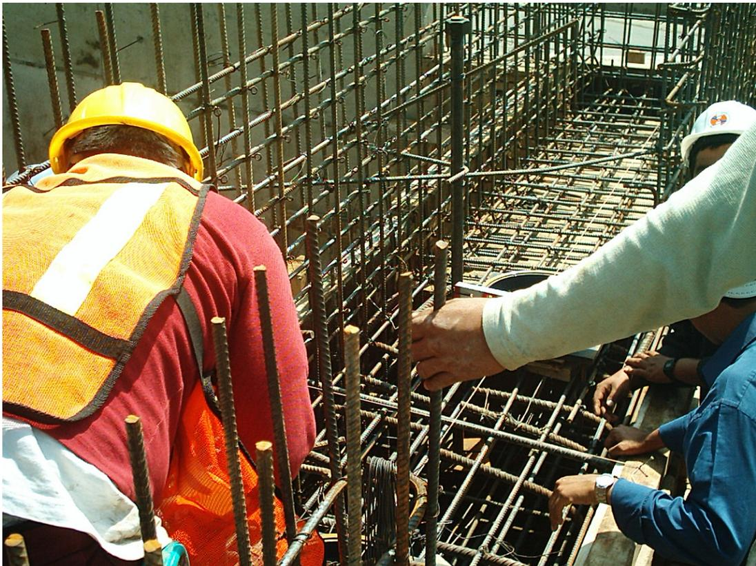
Procesos constructivos que se desarrollan en base a la norma ISO 9000:2000, en este caso para el armado de acero de refuerzo de la cimentación superficial.
