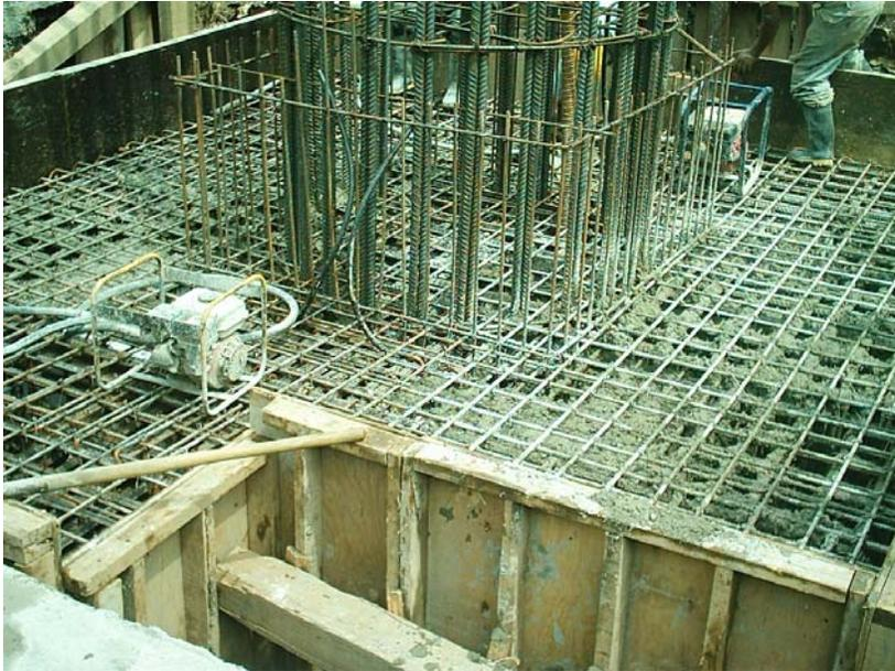
Construcción de cimentación superficial en segundo piso de periférico, la verificación se debió basar en la norma ISO 9000:2000 y por lo tanto en las especificaciones de proyecto
