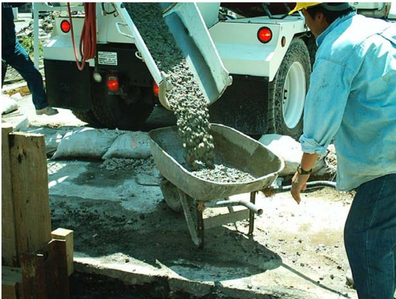
Toma de muestra de concreto  $f'c= 250 \text{ kg/cm}^2$  para construcción de pilas de cimentación. PIP
