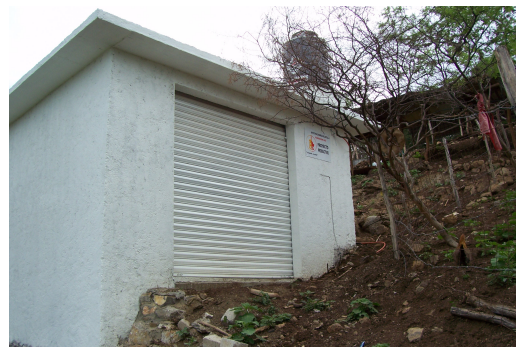
Figura 9. Cuarto de concreto.
