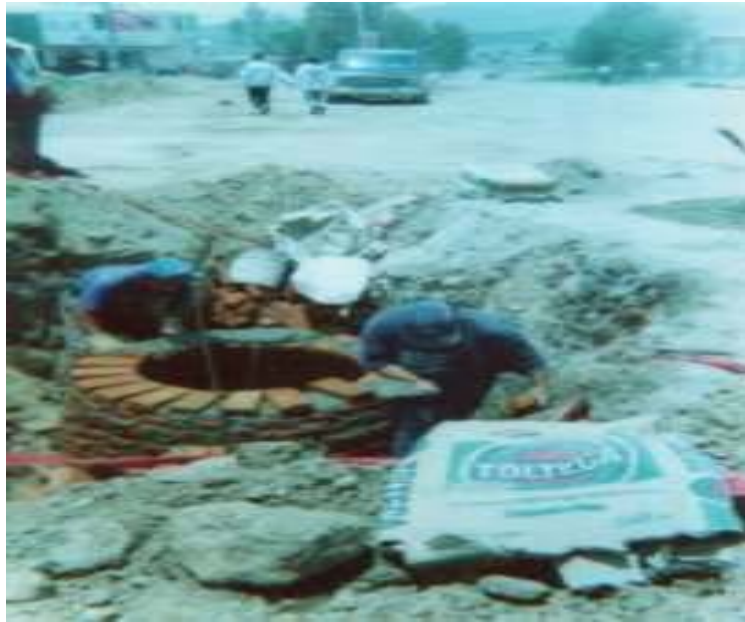
Fotografía 5.3 Construcción de pozo de visita.
