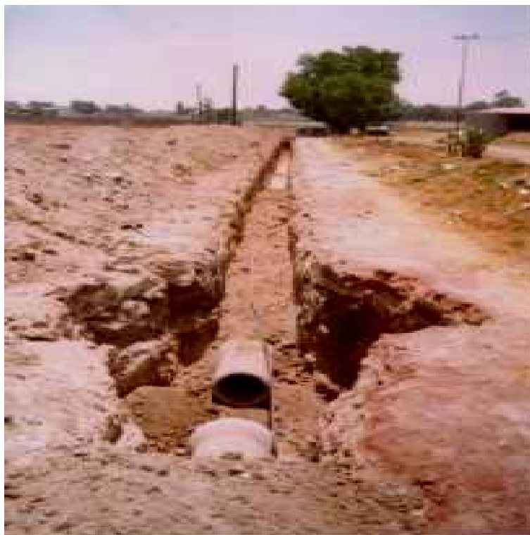
Fotografía 5.4 Relleno con material producto de banco y preparación para pozo de visita.
