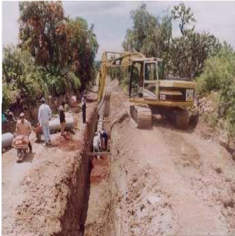
Fotografía 5.2. Excavación de zanja, plantilla y colocación de tubería ayudado por excavadora
