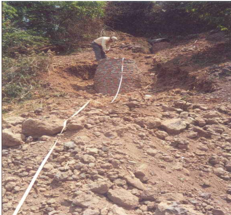
Fotografía.5.1 Alineación y pendiente de pozo de visita
