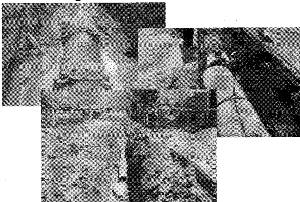
Figura 2.1 Obras de Alcantarillado
