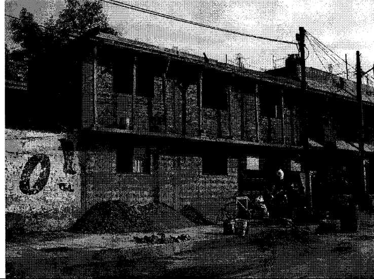
Foto 10.- Colado de la losa del 2do. Nivel.
