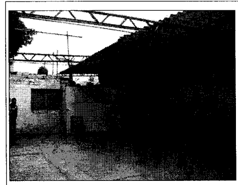
Estado Inicial de la Vivienda
