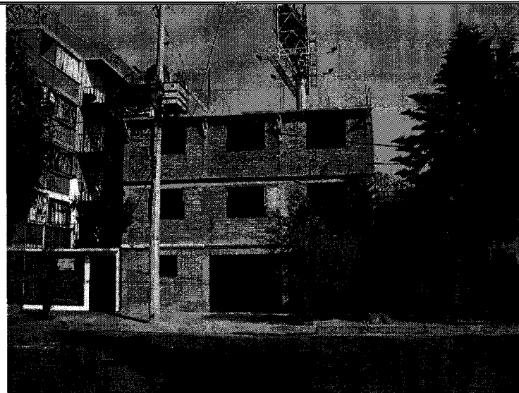
Foto 14.- Terminación del 3er. Nivel.
