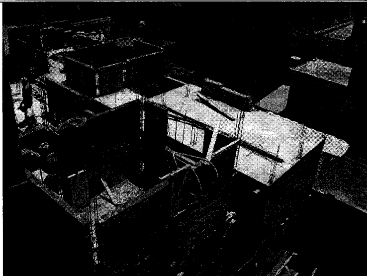
Foto 7.- Armado de la losa del 1er. Nivel.
