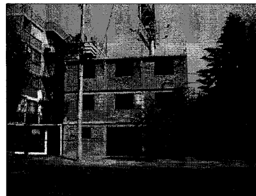
Estado Final de la Vivienda
