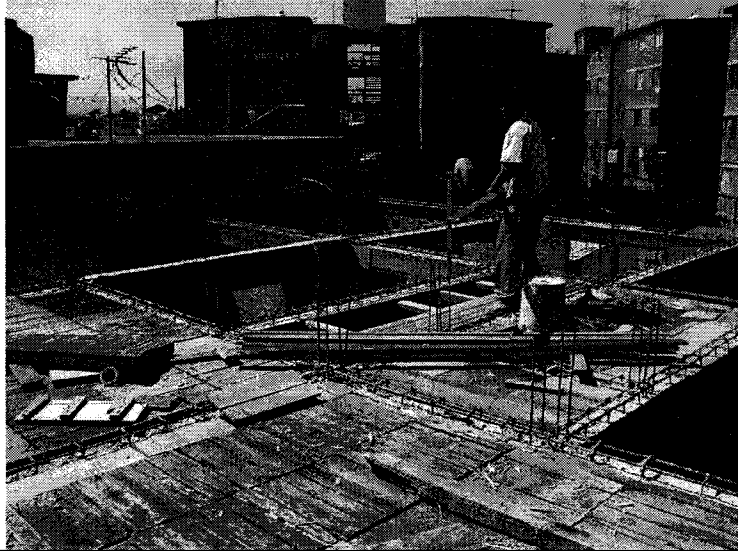
Foto 9.- Cimbrado para la losa del 2do. Nivel.
