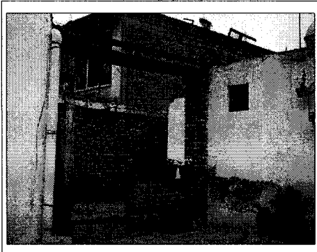
Estado Inicial de la Vivienda
