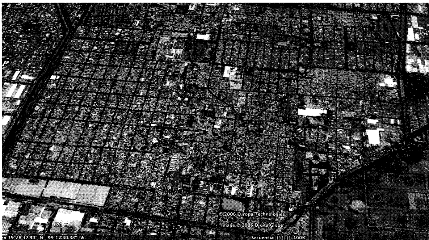
Zona sur del Territorio. A la izquierda colindando con Av. Las Armas se encuentra la colonia Ampliación San Pedro Xalpa, en la parte central el Pueblo de Santiago Ahuizotla y a la derecha el Pueblo de San Miguel Amantla, colindando con la Av. Tezozómoc.
