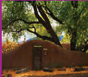
Detalle de barda de tierra
