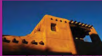
Detalle de Casa en Santa Fe, Nuevo México
