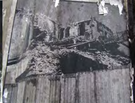
Fotografía-Derrumbe de Casa Requena
