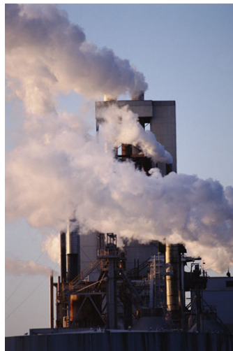
Ilustración 1.7- Generador de vapor
