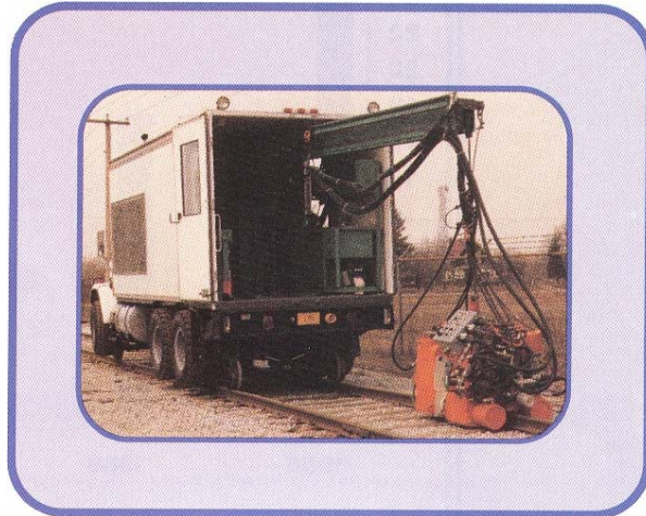
Ilustración 1.8- Soldadura de vías ferroviarias
