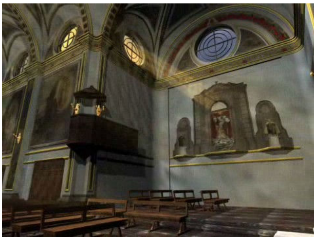
Interior del templo, se observa el púlpito y los lunetos de la bóveda
