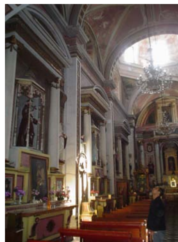
Fotografía de los altares laterales y la base de la cúpula.
