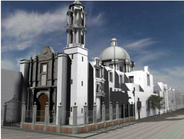
Vista general del templo en la esquina de la 13 oriente y 2 Sur.
