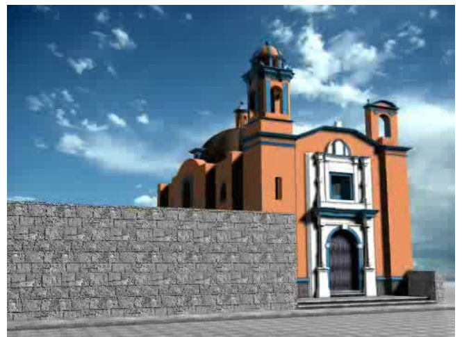
Fachada principal, se aprecia el pequeño atrio y su torre inconclusa.
