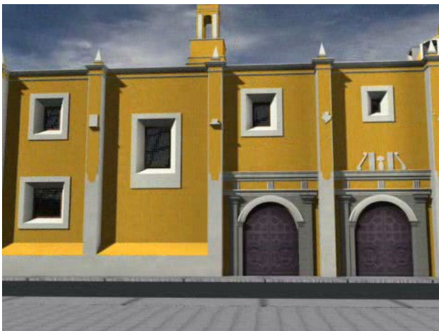
Fachada lateral del templo.
