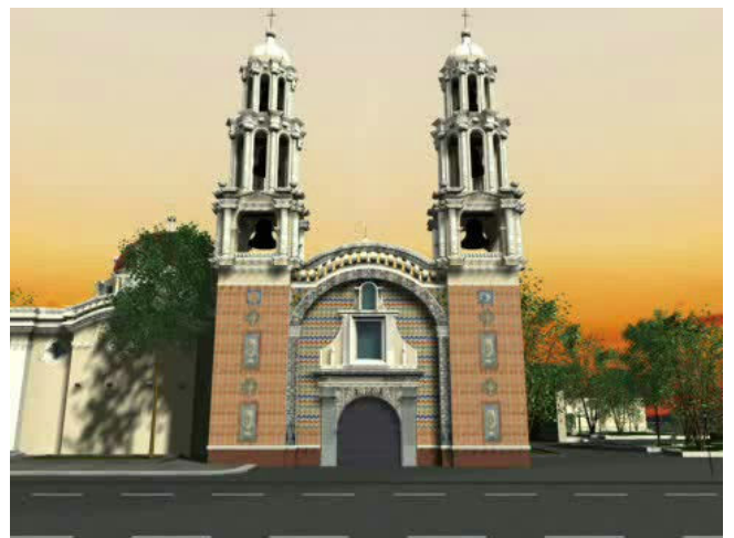
Fachada principal, se observa el recubrimiento de ladrillo muy propio de loas construcciones poblanas.
