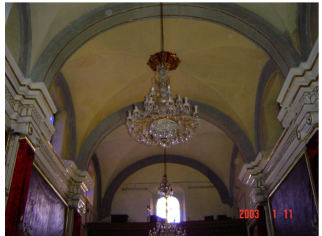
Fotografía del interior viendo la parte alta del coro, se aprecian las bóvedas de pañuelo y los lunetos laterales.
