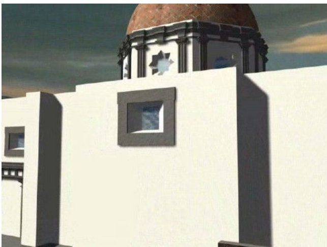
Cúpula vista desde la calle lateral, se pueden observar los óculos en forma de estrella abocinada.
