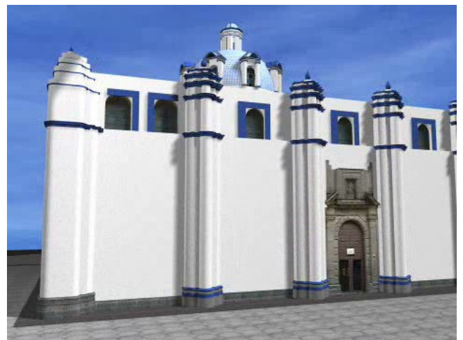
Vista general del templo, se aprecian sus grandes contrafuertes de perfil mixtilíneo.
