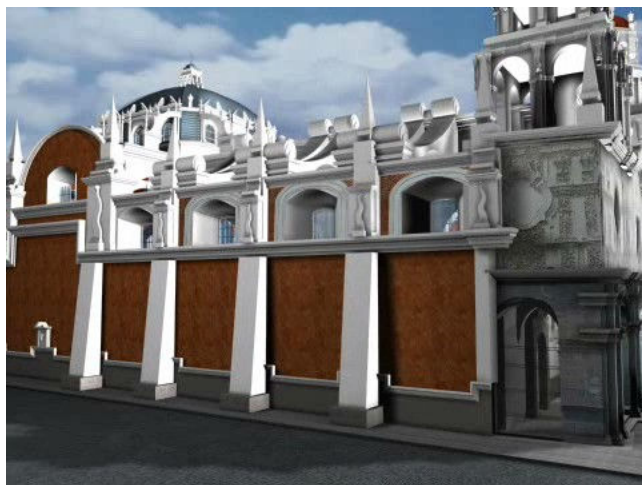
Vista de la fachada sobre la Av. Maximino Avila Camacho, los contrafuertes se colocaron después del terremoto de 1999.
