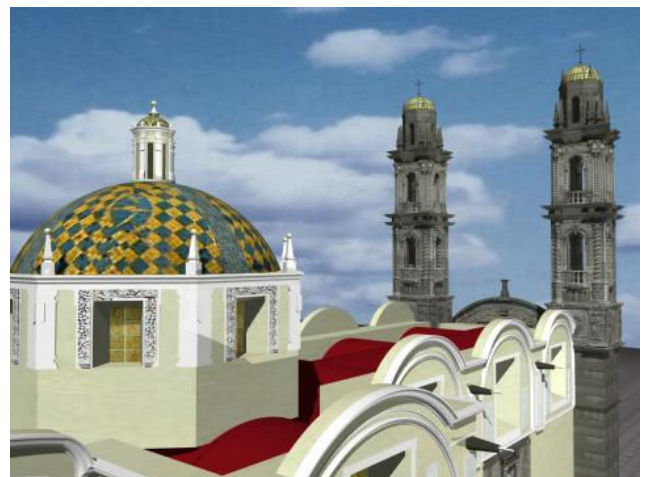
Cúpula con tambor y base ochavada al fondo las esbeltas torres de los campanarios.
