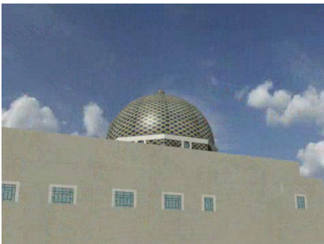
Cúpula recubierta de azulejo.
