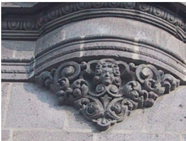
Detalle de cantería en la fachada.
