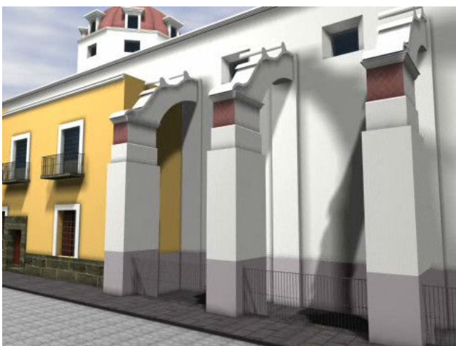
Contrafuertes en la fachada poniente, sobre la 9 Norte.
