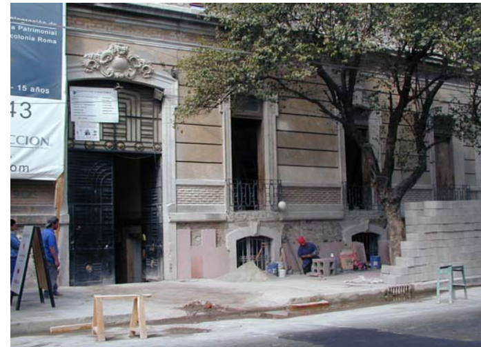
Fachada a la calle de Mérida en etapa de restauración
