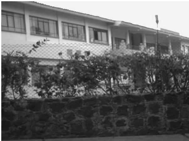
FOTO 46. Edificio de Hospitalización.
