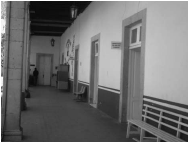
FOTO 18. Área de Servicios Auxiliares.
