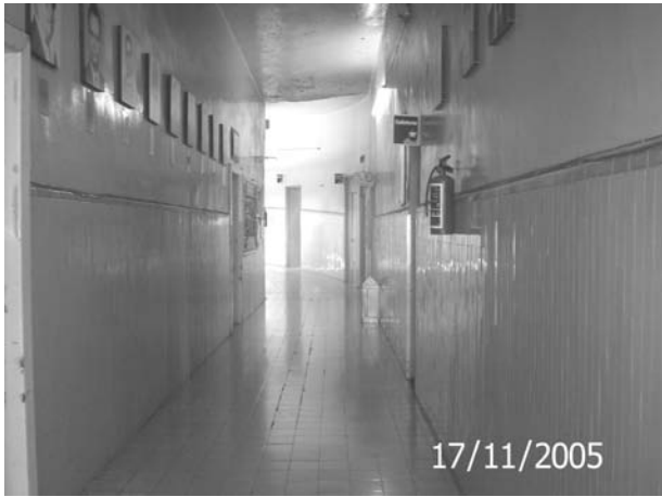
FOTO 45. Pasillo que conecta el ingreso actual con Hospitalización.
