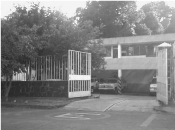
FOTO 15. Edificio Norte. Escuela de Capacitación
