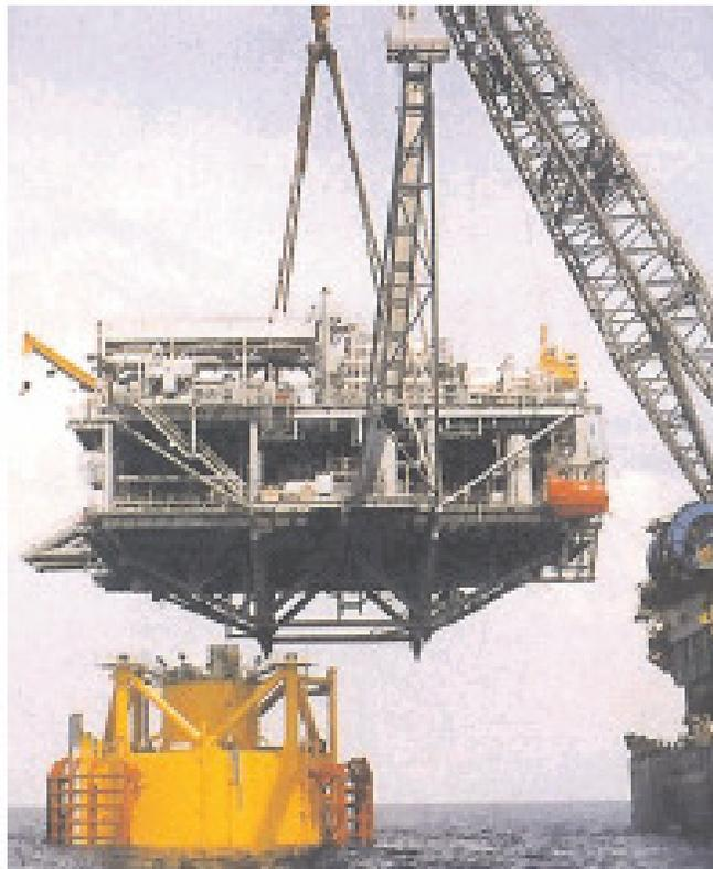
**Figura II.5** Cubierta en instalación.
