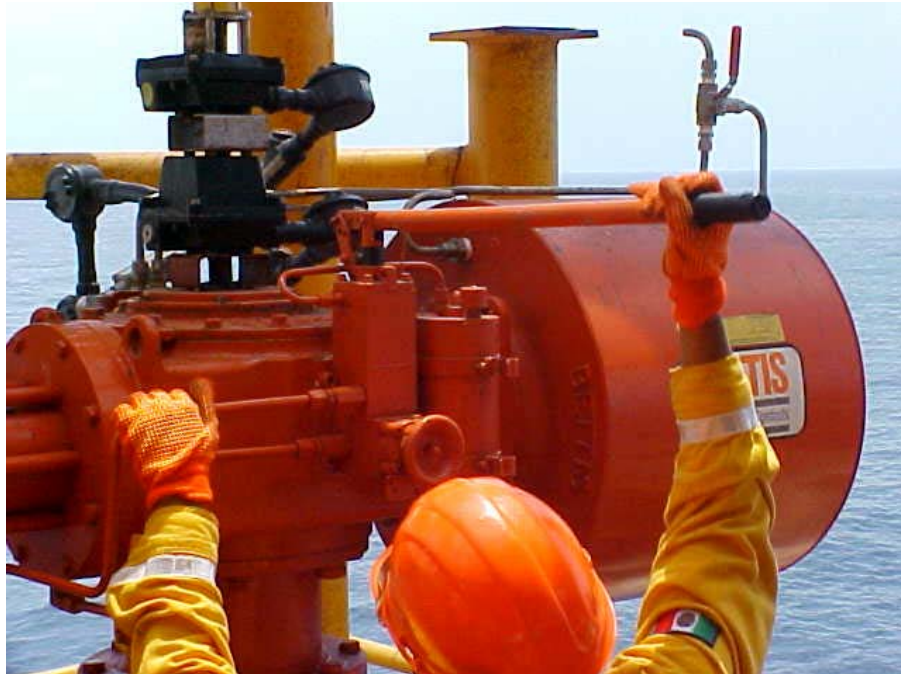
Fig.2.3 Válvula de tipo hidroneumático de doble acción.
