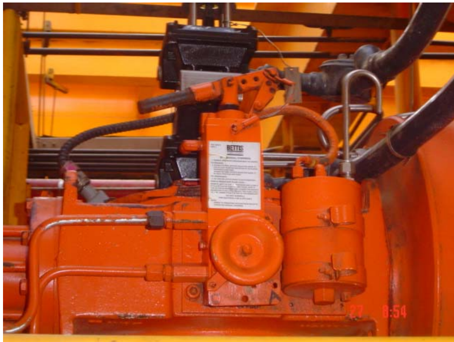
Fig.2.4 Actuador tipo hidroneumático de doble acción marca Betts.
