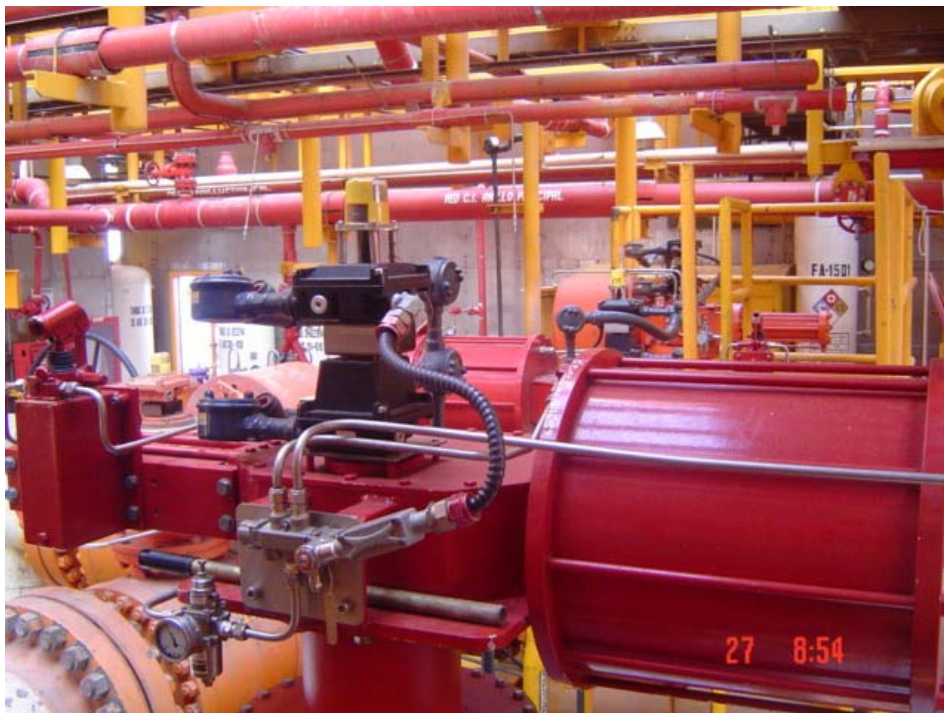
Fig.2.6 Actuador tipo hidroneumático de doble acción marca Rotork.
