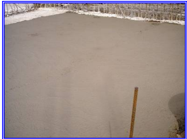
En esta imagen se ve la colocación de la plantilla de concreto terminada.
