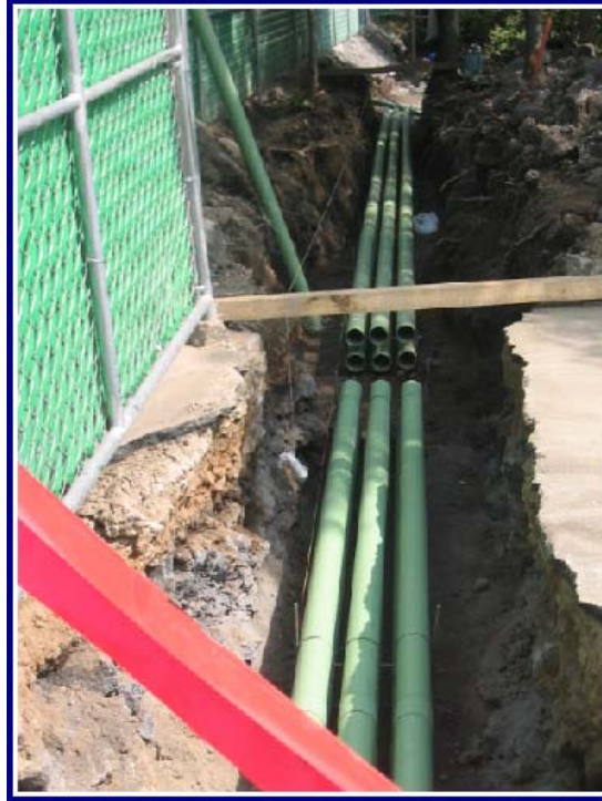
Reubicación de la línea de alta tensión en el costado oeste de la zona de la obra
