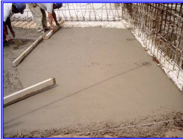
En esta imagen se ve la colocación de la plantilla de concreto terminada.
