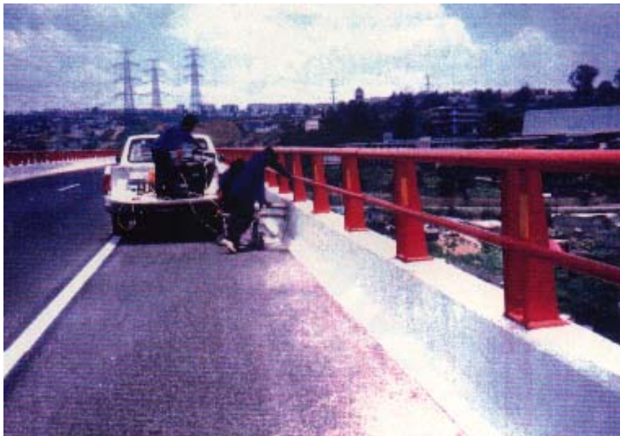
Figura IV.3. Calzada del Puente.
