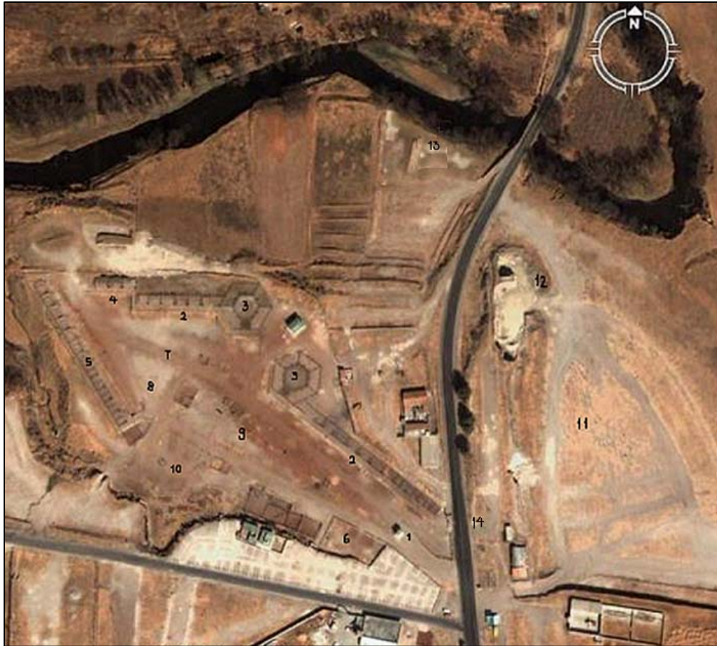
FIGURA 8. Vista Panorámica del Mercado del Puente de San Bernabé Fuente: Google hearth, digital globe, puntero 19°28'13.67" Europa Technologies 2007.
