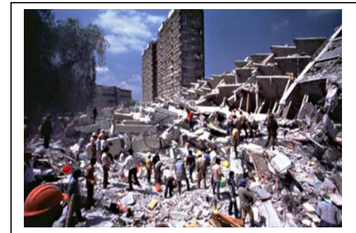
Fotografía 3.7 Hospital Juárez de México, destruido en el terremoto de 1985.
