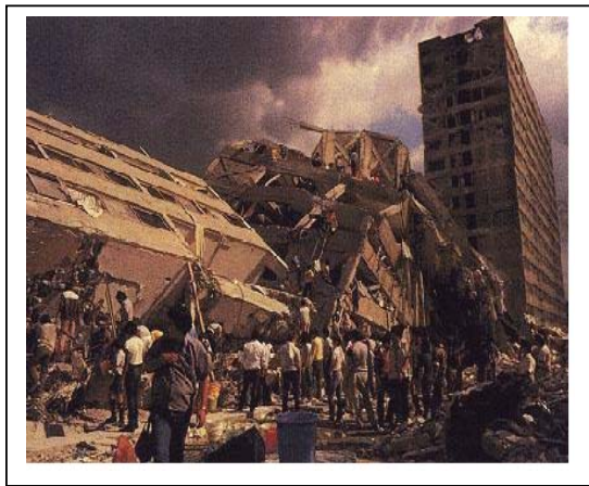
Fotografía 3.6 Hospital Juárez de México, destruido en el terremoto de 1985.
