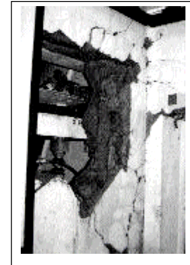
Fotografía 3.3 Daño no estructural en el hospital de Antofagasta, por el sismo del 31 de julio de 1995. Chile
