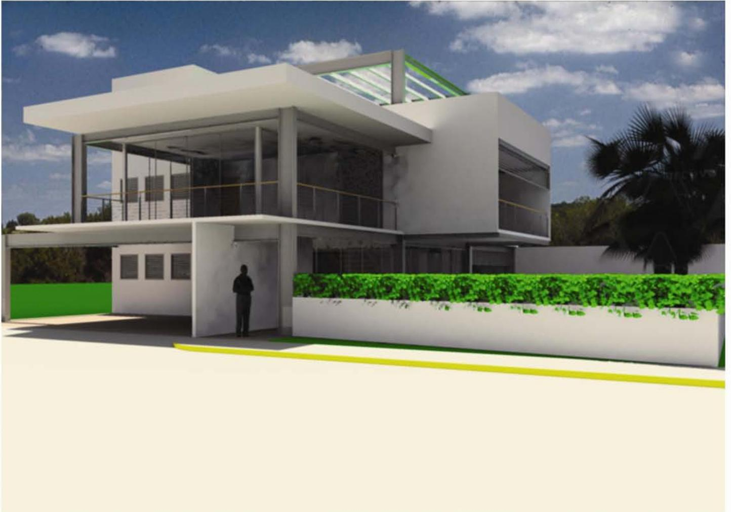
ACABADOS DE ACERO GALVANIZADO, HERRERÍA DE ALUMINIO, CRISTAL TEMPLADO Y PANEL W CON CUBIERTA DE CONCRETO Y ESMALTE ALQUIDÁLICO BLANCO PARA EXTERIOR.
