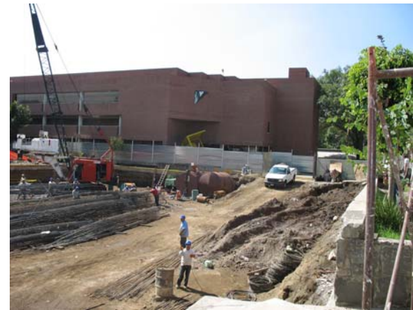
Proceso de excavación
