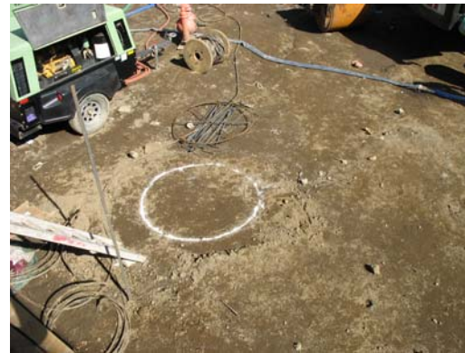
34. (izquierda) Maquinaria (derecha) Trazo de localización del pilotaje.
