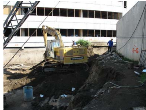
33. (izquierda) Armado de pilas (derecha) Excavación de terreno.
