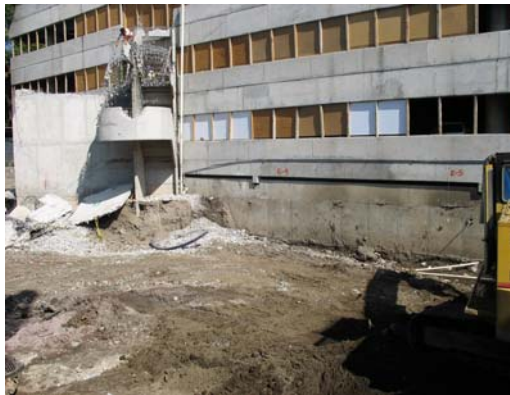
37. (izquierda) Perforación para el incado de pilas (derecha) Potecciones a edificios colindantes con tapiales.
