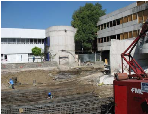
38. (izquierda) Terreno por excavar (derecha) Armado de pilas.
