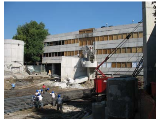
32. (izquierda) Demolición de escalera existente (derecha) Armado de pilas.
