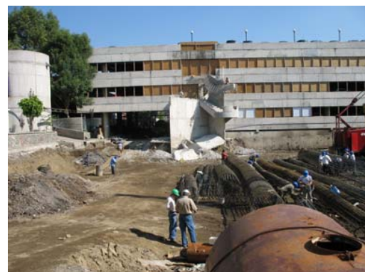
35. (izquierda) Trazo de localización del pilotaje (derecha) Armado de pilotaje.
