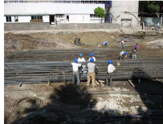
31. (izquierda) Excavación de terreno (derecha) Armado de pilas.
