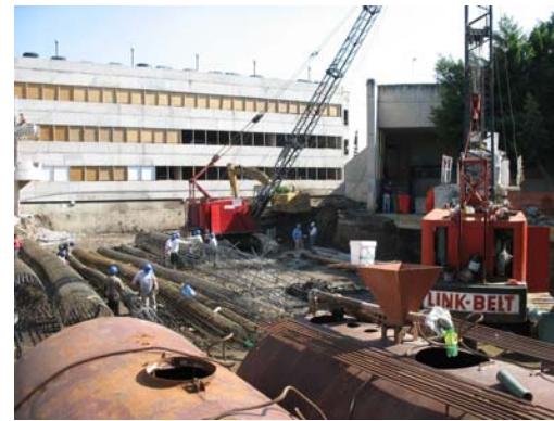
36. (izquierda) Armado de pilas (derecha) Equipo y maquinaria.
