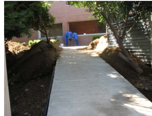
40. (izquierda) Depositos de agua (derecha) Habilitado de rampas para edificios colindantes
