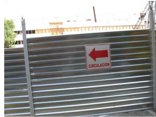
39. (izquierda) Armado de pilas (derecha) Tapiales y enlalmientos
