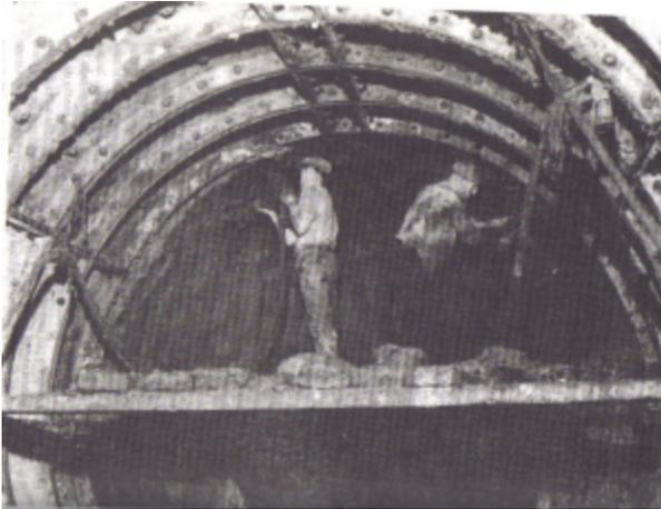
Fig. II-38 Excavación sin ademe para revestimientos de hierro colado en arcilla compacta<sup>(5)</sup>
