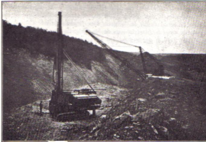
FIG II-31 Barreno de Pistón (Ingersoll-Rand Co.)<sup>(6)</sup>
