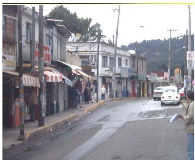
Fig. 16 Vivienda de autoconstrucción
