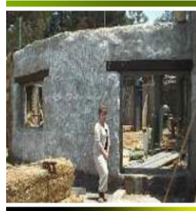
Fig. 23 La paja ofrece un aislante térmico
