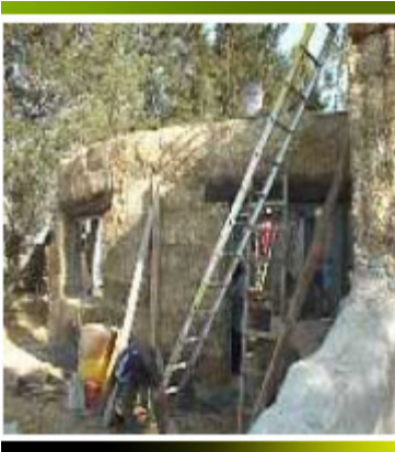
Fig. 22 Muros construidos a base de paja
