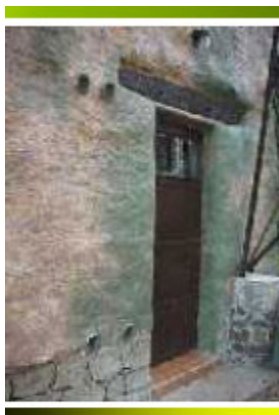
Fig. 26 Fresquera vista desde el exterior Iluminación natural:
