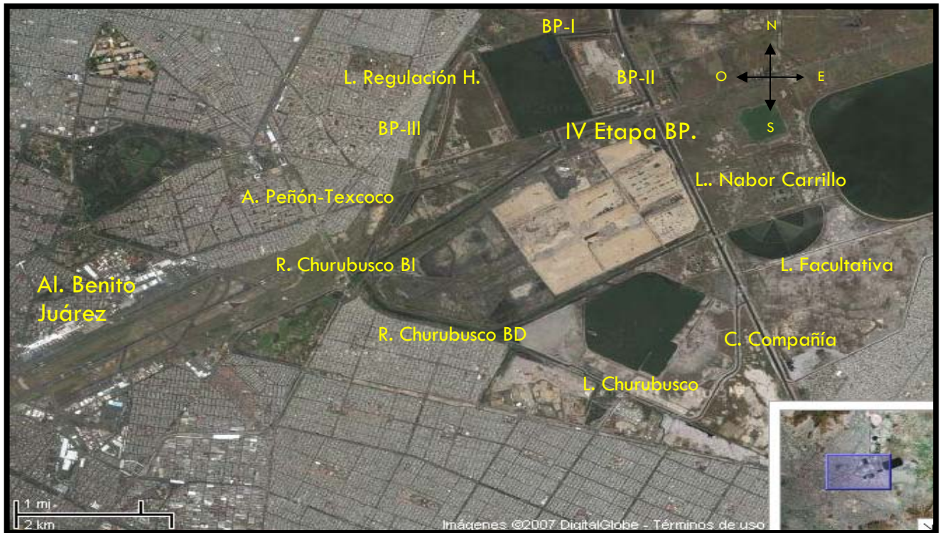
Fig. 7. Ubicación de la IV etapa del relleno sanitario Bordo Poniente, Edo. De México. Fuente: Google earth, 2007.
