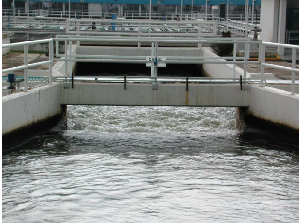
Fig. 6 Canales de floculación “Berros”.
