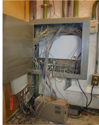
Servidores. Switches atornillados directamente en pared, desorden en la llegada de cableado
