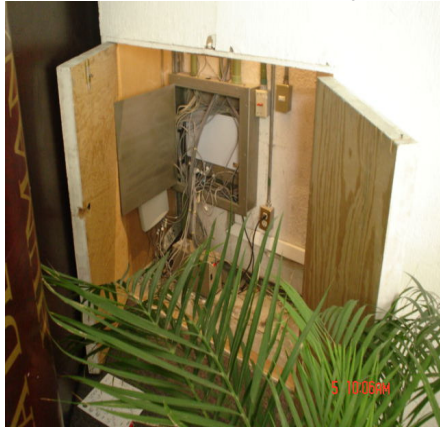
Servidores. Switches atornillados directamente en pared, desorden en la llegada de cableado
