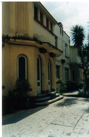
Foto 293 Interior del conjunto
