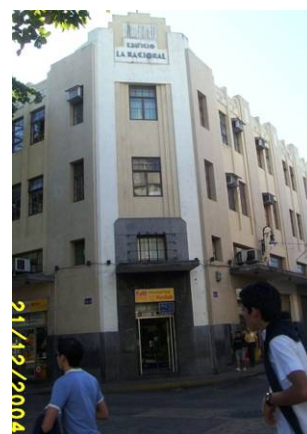
Foto 28. Edificio La Nacional
