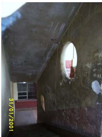
Foto 309 cubo de escaleras
