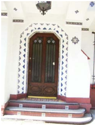
15 Casa habitación Arq. Juan Segura y Ricardo Dantán. 1928 Av. México núm. 25 Col. Hipódromo Foto 201
