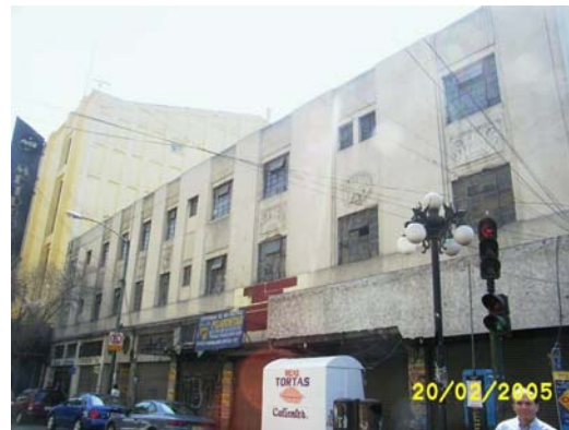
3 Edificio de departamentos C/ Independencia núm. 104 o Balderas núm. 50 Col. Centro Foto 54
