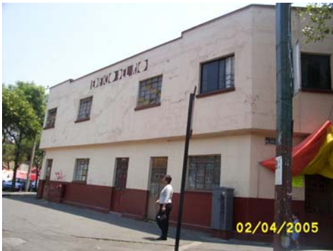
5 Casa Habitación Edificio del Río Dr. Velasco núm. 90 Col. Doctores Foto 109
