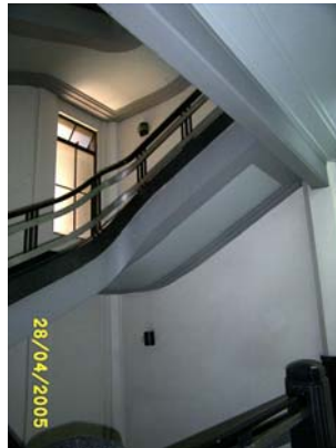
Foto 234 Núcleo de escaleras
