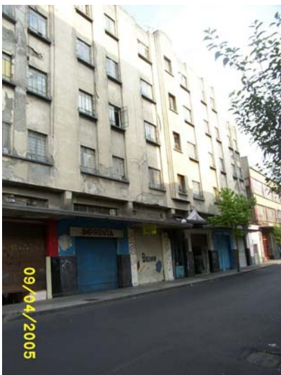
12 Edificio habitacional Allende núm. 117 Col Centro Foto 68
