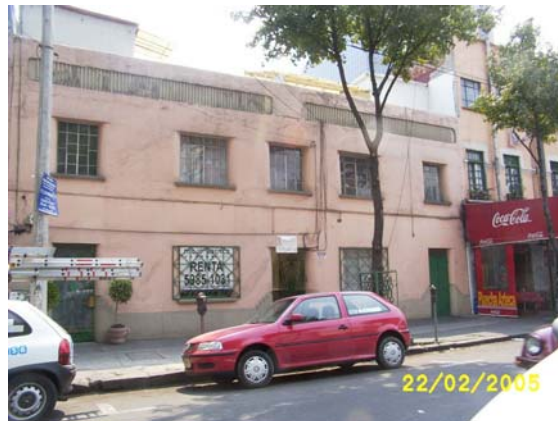
3 Edificio Iberia Lerma núm. 50 Col. Cuauhtémoc Foto 86
