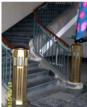
Foto 363 Escalera principal y original
