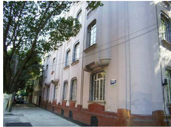
34 Edificio Parras Parras No. 22 y Av. Nuevo León núm. 28 Col. Hipódromo Foto 220
