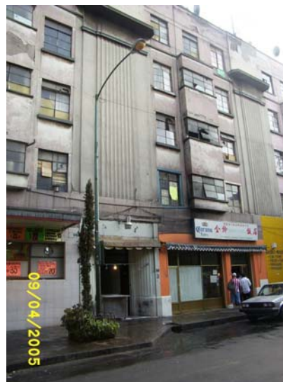
13 Edificio habitacional Mesones núm. 86 Col Centro Foto 69
