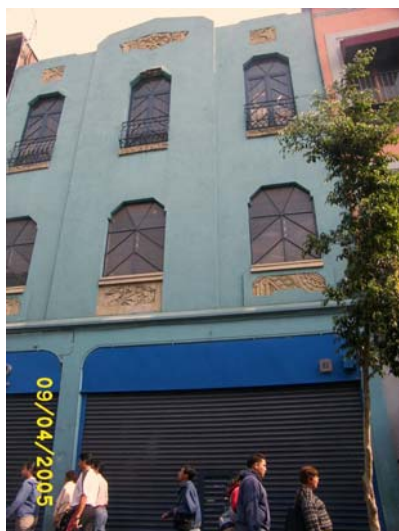
22 Edificio habitacional Tacuba núm. 62 Col Centro Foto 78
