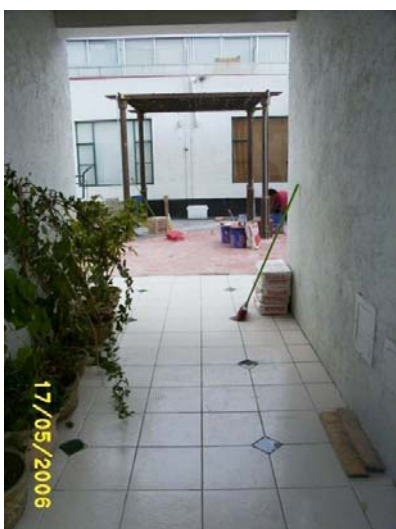
Foto 351. Roof garden en construcción. Eje y remate visual
