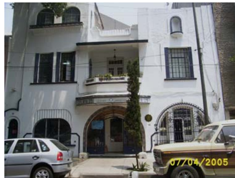
4 Edificio Habitacional Celaya núm. 25 1928-1935 Arq. Juan Segura y Ricardo Dantán Col. Hipódromo Foto 204
