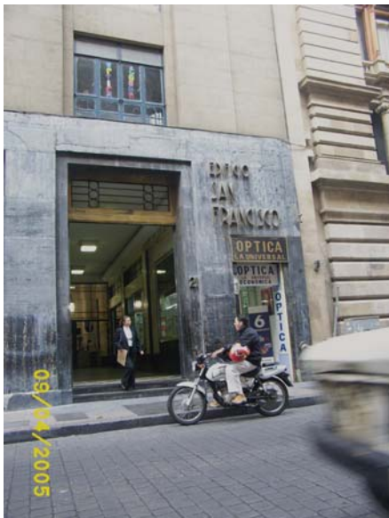
18 Edificio San Francisco Bolivar núm. 21 Col Centro Foto 74
