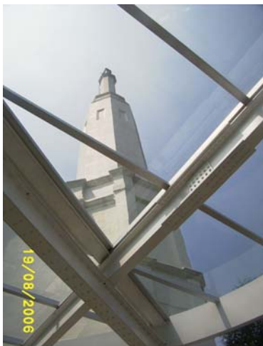
Foto 357. Vista desde la cubierta
