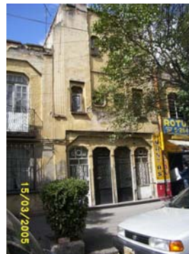
3.5 Casa habitación Coahuila núm. 198 Col. Roma Norte (antes de remodelación) Foto 147
