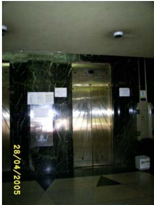
Foto 233 Núcleo de elevadores
