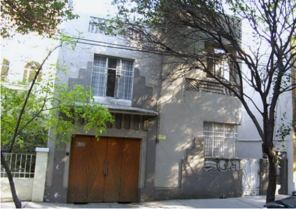
29 Casa Habitación Arq. Francisco Serrano 1931 Av. Amsterdam núm. 110 Col. Hipódromo Foto 215
