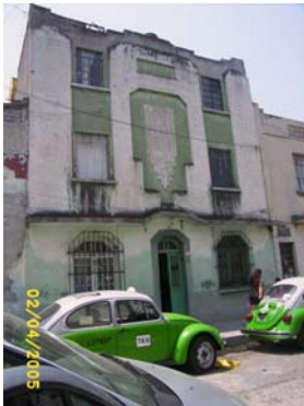
Foto 107 Casa habitación en Dr. Villada. 5A
