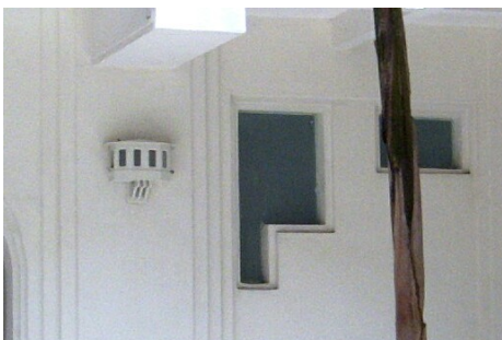
Foto 368 Detalle de luminaria y ventana
