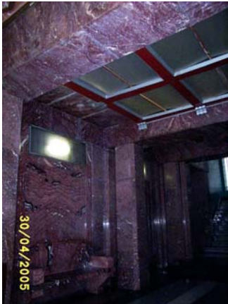
Foto 258 Vestibulo del edificio
