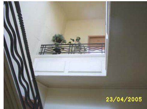
Foto 347. Barandales y descansos
