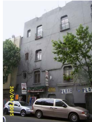
25 Edificio habitacional República de Venezuela núm.25 Col Centro Foto 81
