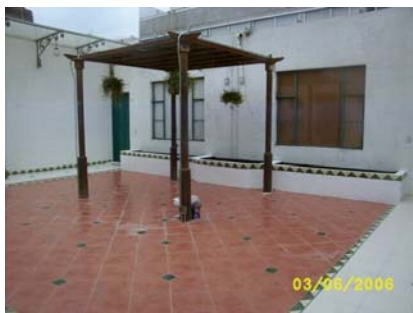
Foto 350. Roof garden en construcción. Centro
