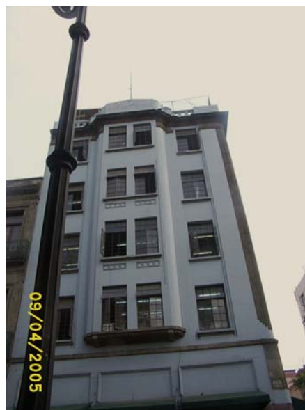
19 Edificio 16 de septiembre 16 de septiembre núm. 48 Col Centro Foto 75
