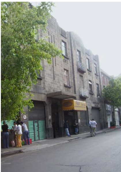
16 Edificio habitacional Mesones núm. 26 Col Centro Foto 72
