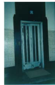
Foto 289 Elevador y acceso principal
