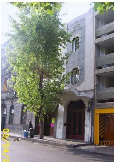
14 Edificio Sancho Midvel Mesones núm.59 Col Centro Foto 70
