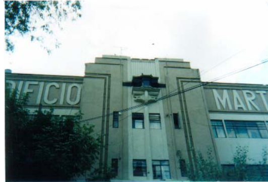
42 Edificio Marti Sindicalismo núm. 87 Col. Hipódromo Foto 228
