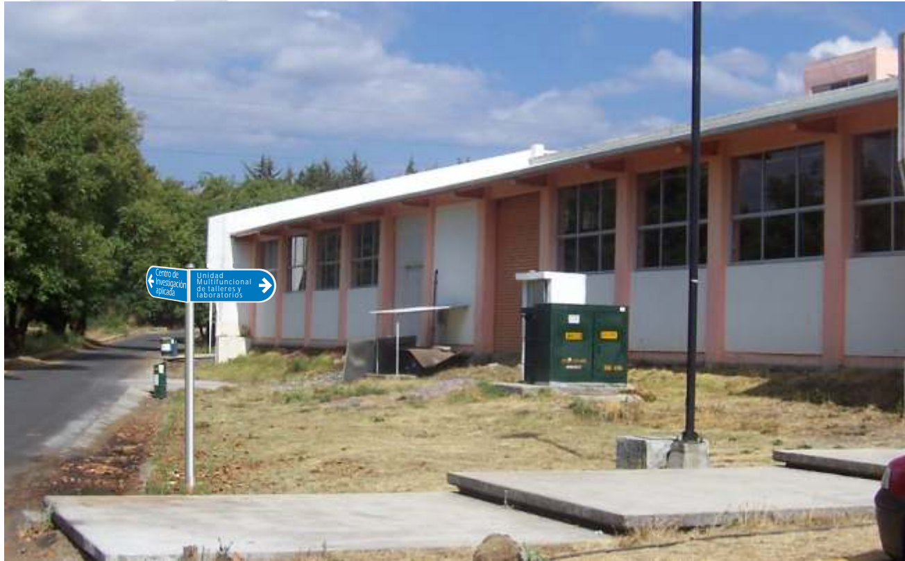
Unidad Multifuncional de Talleres y Laboratorios
