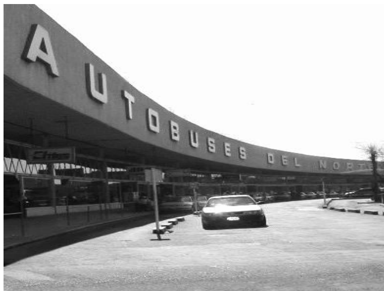
Terminal Central de Autobuses del Norte Fuente: www.centraldelnorte.com.mx
