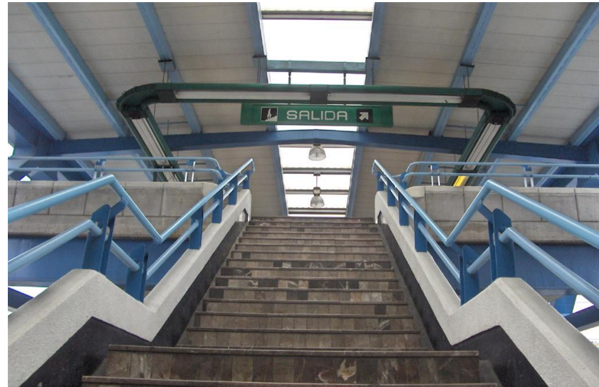
Escalera de Salida. Estación metro Iztacalco Fuente: SkyscraperCity Forums. Copyright ©2000-2006, Jelsoft Enterprises Ltd
