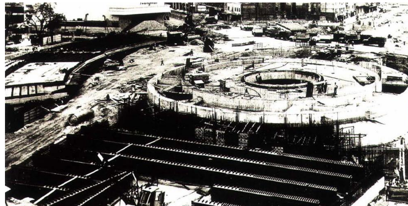
Glorieta Insurgentes. Etapa de Construcción línea 1 del metro. Fuente: 30 años de hacer el metro. ICA, 1a. Ed. México 1997
