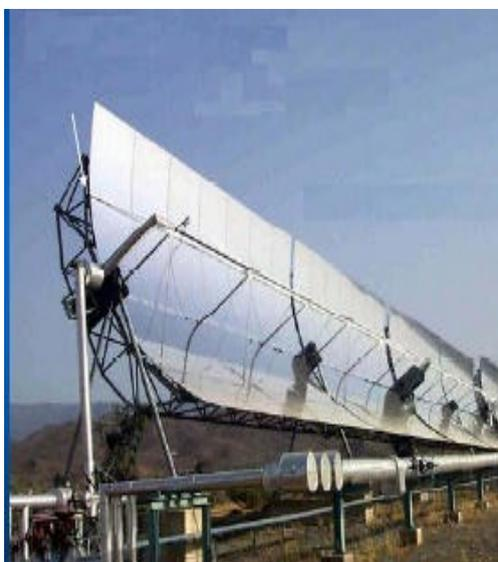
Figura 2.4 Concentrador CP de un grado de libertad.
