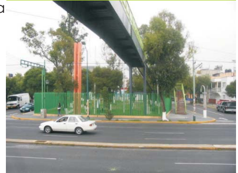
Puente peatonal sobre Eje 3
