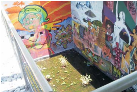
Pinturas sobre los muros
