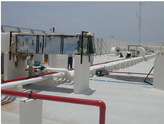
Ductos de instalaciones afectados en alojados en azoteas.
