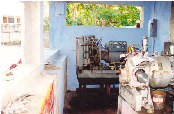
Figura II.III Se muestra cuarto de maquinas sin ningún tipo de seguridad contra incendio
