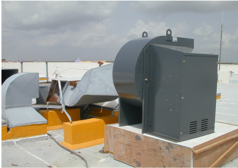
Ductos de instalaciones afectados en alojados en azoteas.
