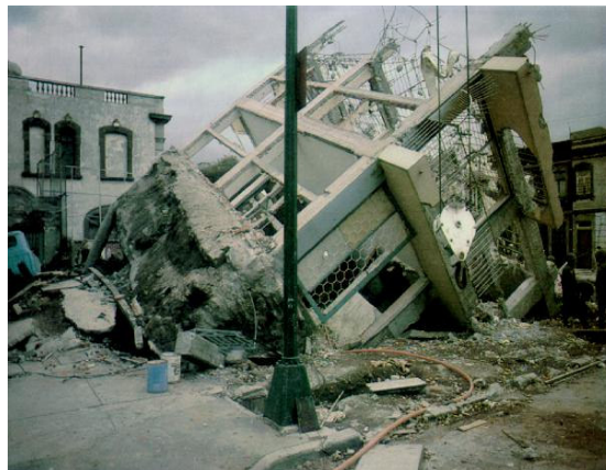
Figura I.XV Imagen de un edificio dañado por sismo
