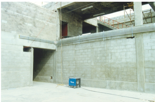
Figura II.II Muros de separación contrafuego para confinamiento de un posible incendio
