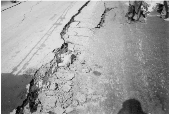
Figura III.III (A) La imagen refiere a un plano de falla con un patrón de ruptura por corrimiento, manifestada sobre una superficie de rodamiento.
