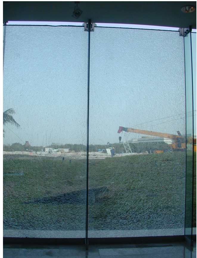
Reposición de cancelería en fachada principal.
