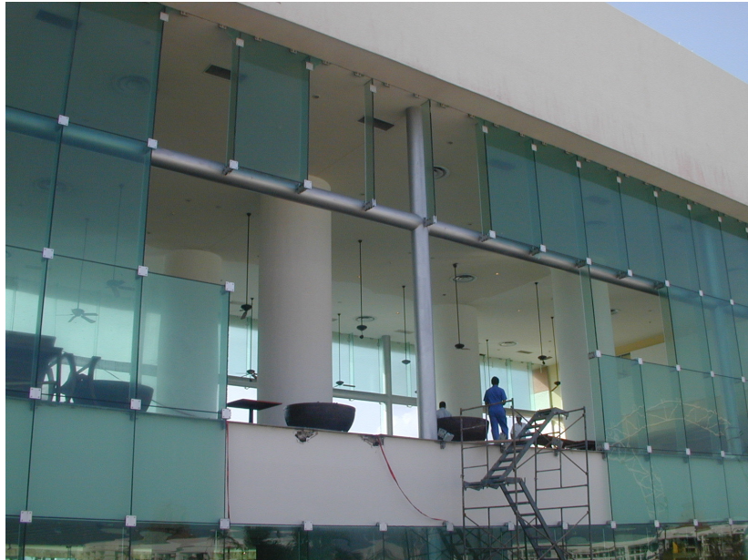
Reposición de cancelería en fachada principal.
