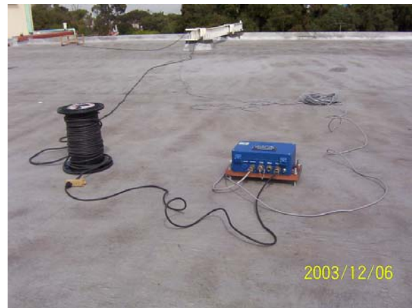
Figura 3.6 Detalle de instrumento instalado en el techo
