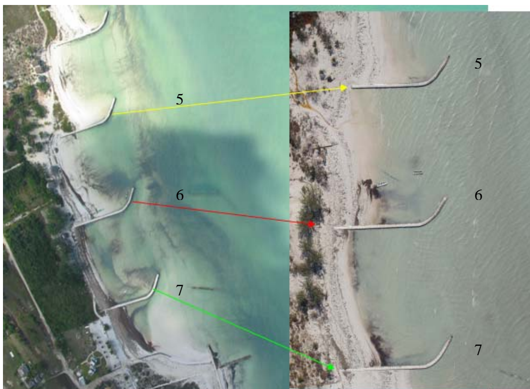
Figura 16a. Donde se señala el efecto de la erosión por el huracán en los espigones 5, 6.
