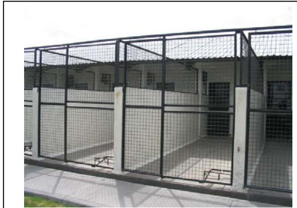
Dormitorios de perros adultos con un área techada al exterior
