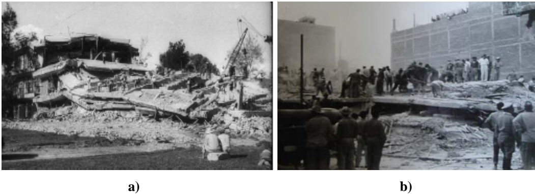
Figura 2.4 Colapsos totales: a) Escuela Superior de Ingeniería y Arquitectura, IPN y b) Edificio en esquina de las calles de Frontera y Álvaro Obregón.
