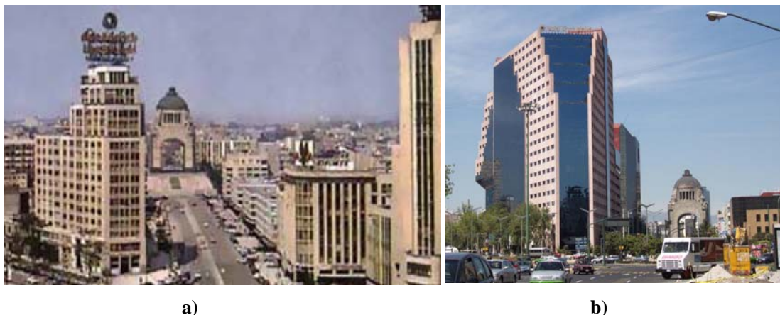
Figura 2.17 a) edificio Corcuera (57-Corcu en tabla 2.1) ubicado en esquina y con planta muy irregular por encontrarse en un cruce de calles en diagonal, fue demolido después del sismo por los daños tan severos que sufrió y b) edificio actual en la misma esquina con características muy similares al anterior.
