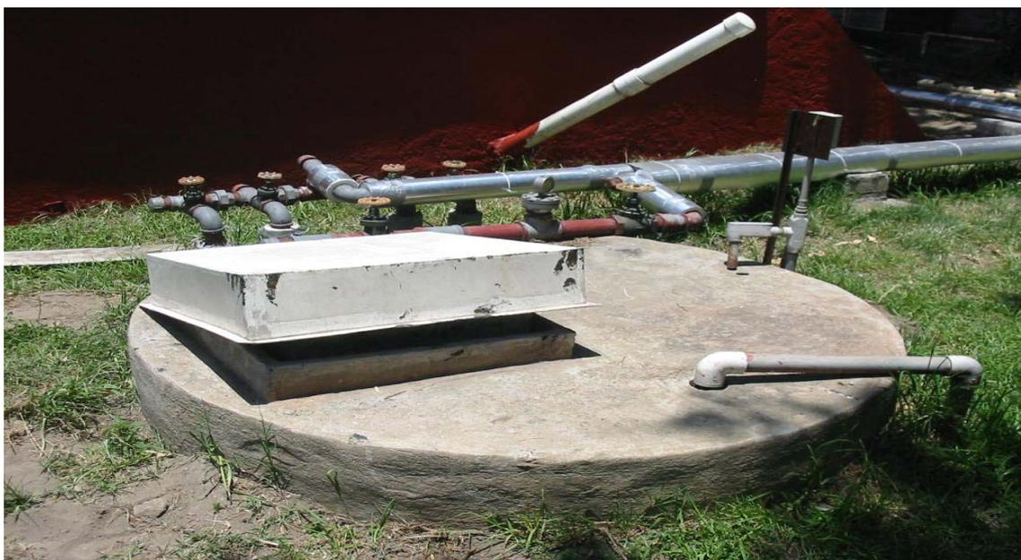
Figura A.1. Cárcamo de llegada de lodos para su posterior alimentación y puerto de muestreo
