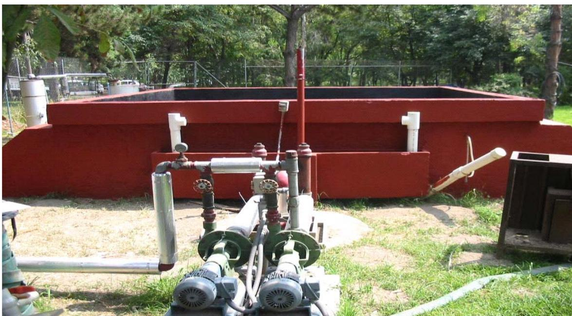
Figura A.2. Vista lateral del reactor UASB, bombas de recirculación de efluente y puerto de muestreo
